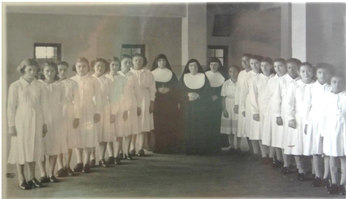
Fotografia 22 - Alunas da Escola Doméstica do Colégio Nossa Senhora Auxiliadora
