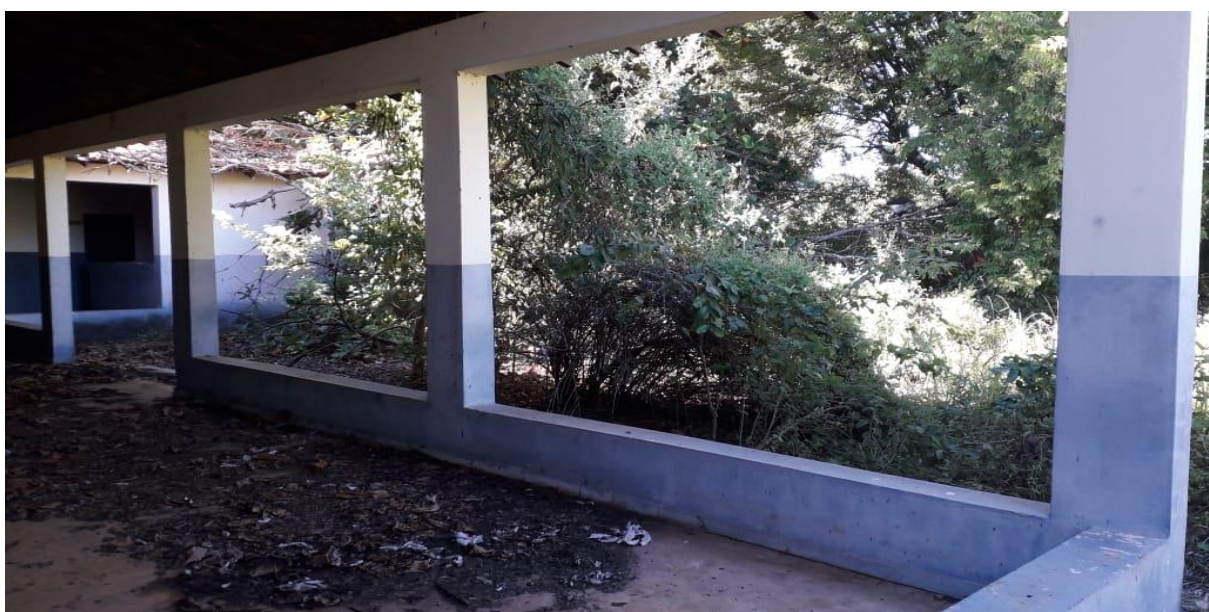
Figura 13 - Área Interna 2 - da Estação Ferroviária de Taunay – Ano 2019
