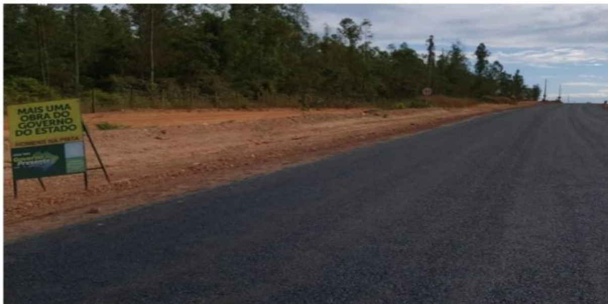
Figura 38 – Trecho da Construção do asfalto que liga a BR 262 ao Distrito de Taunay
