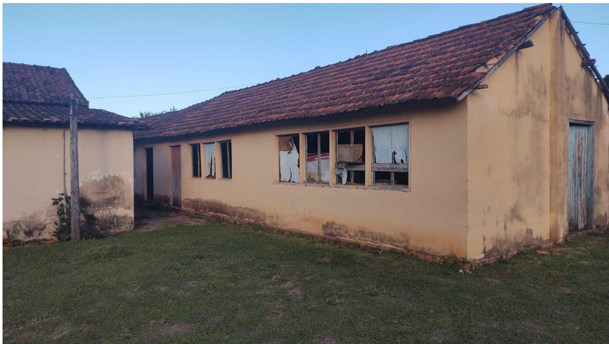
Figura 22 - Vista parcial do Prédio da Escola Particular Evangélica Lourenço Buckman
