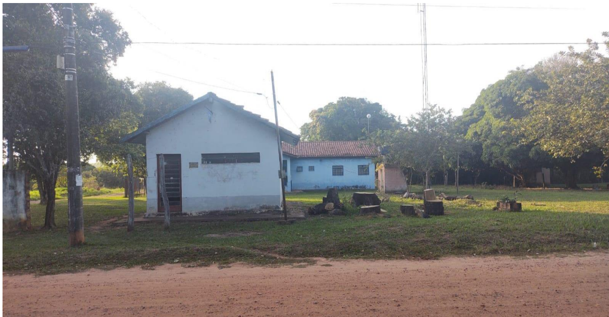
Figura 26 – Prédio do Correio do Distrito - Rua Três Leste
