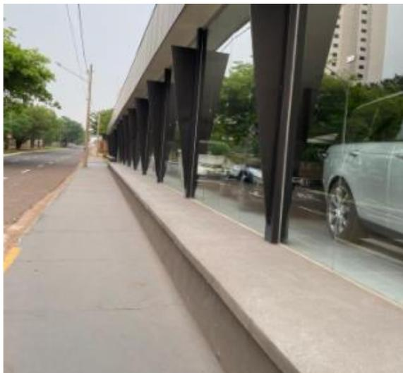
Figura 36 - Exemplo de adaptação das construções nas áreas vulneráveis. Fundações mais altas que o nível da calçada. Dos autores.
