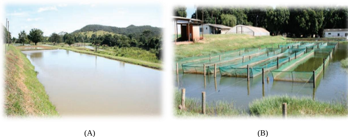
Figura 3. Estruturas para produção de peixe. (A) Viveiro escavado e (B) hapas instaladas em viveiro escavado. Fonte: SENAR (2017) e (2018b).
