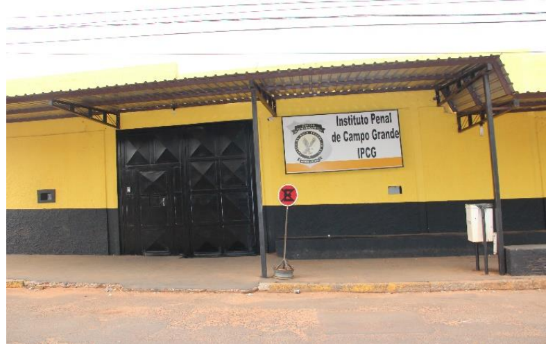
Figura 9 – Fachada do IPCG
