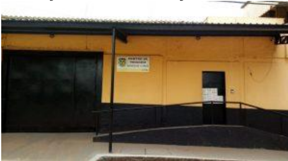
Figura 18 – Fachada do Centro de Triagem “Anísio Lima”
