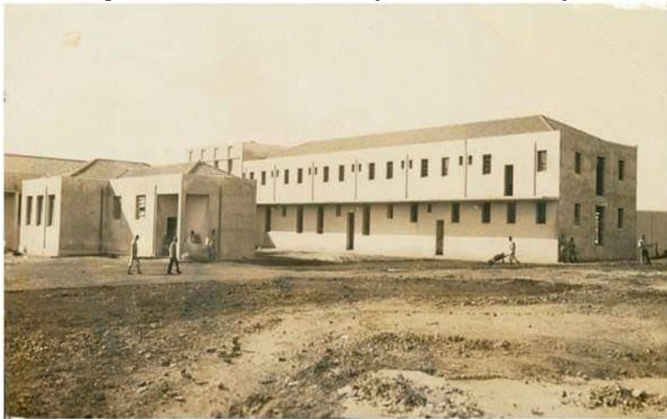
Figura 1 – Presídio Central de Campo Grande em Construção
