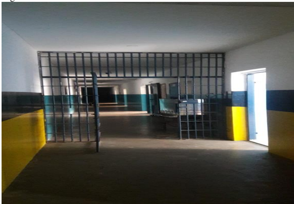
Figura 31 – Corredor de acesso às salas da Extensão da Escola Betine no EPJFC
