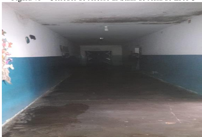
Figura 41 – Corredor de Acesso às Salas de Aula do EPJFC
