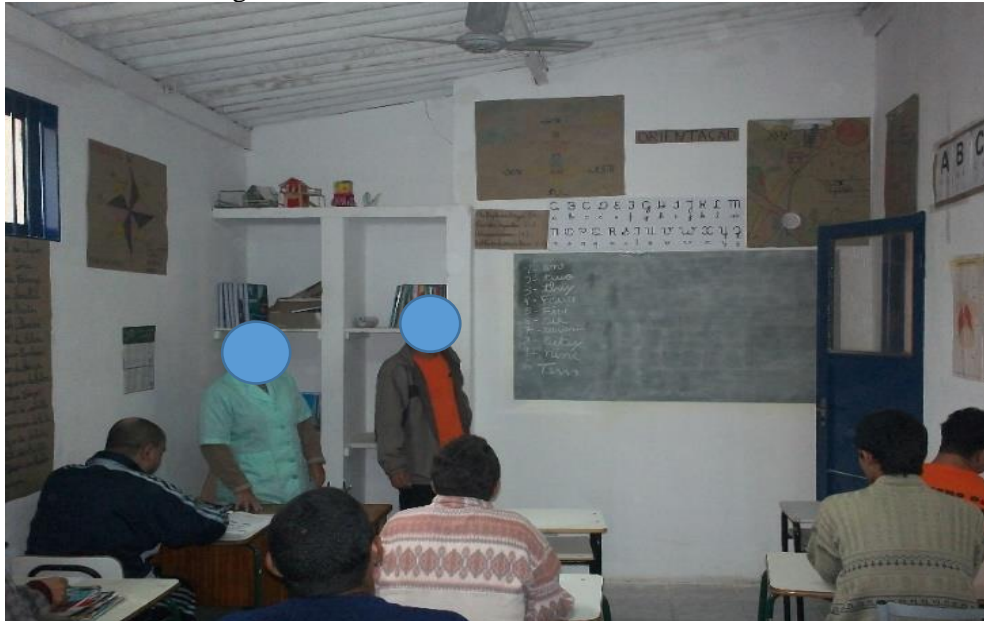
Figura 19 – Sala de Aula CTAL antes da reforma
