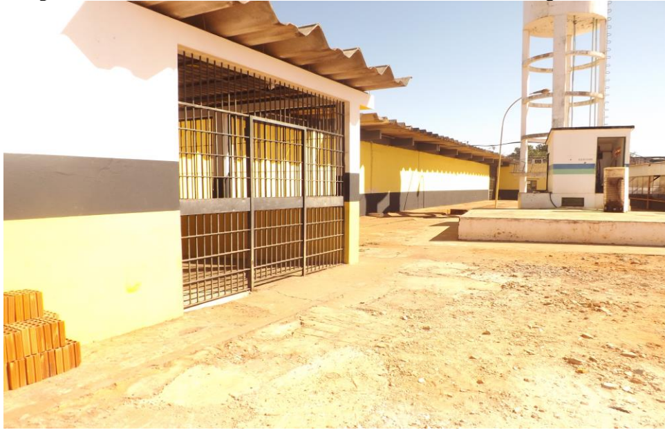
Figura 10 – Portão de Acesso ao Pavilhão II e vista da Caixa d'água do IPCG
