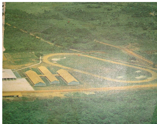
Figura 4 - Foto aérea dos blocos, com parte da quadra de esportes, campo de futebol e estrada de acesso à Instituição.
