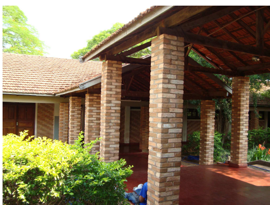
Figura 10 - Área de circulação coberta entre os Blocos 2 e 3. Fonte: Ziliani, 2008.
