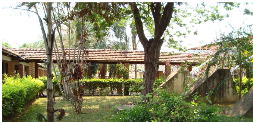
Figura 13 - Área de circulação coberta ligando a quadra ao Bloco 3 (à direita, blocos de concreto de fixação das treliças da quadra ao solo).
