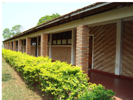
Figura 6 - Bloco 2: Salas de aula (foto). Fonte: Ziliani, 2008.
