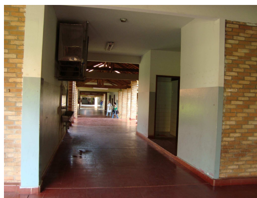
Figura 11 – Bloco 2: Área de circulação coberta, acesso aos banheiros. Fonte: Ziliani, 2008.
