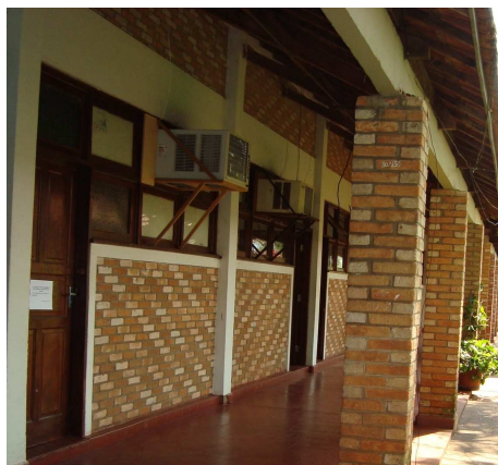
Figura 9 – Bloco 3: Foto das esquadrias (janelas/portas). Fonte: Ziliani, 2008.
