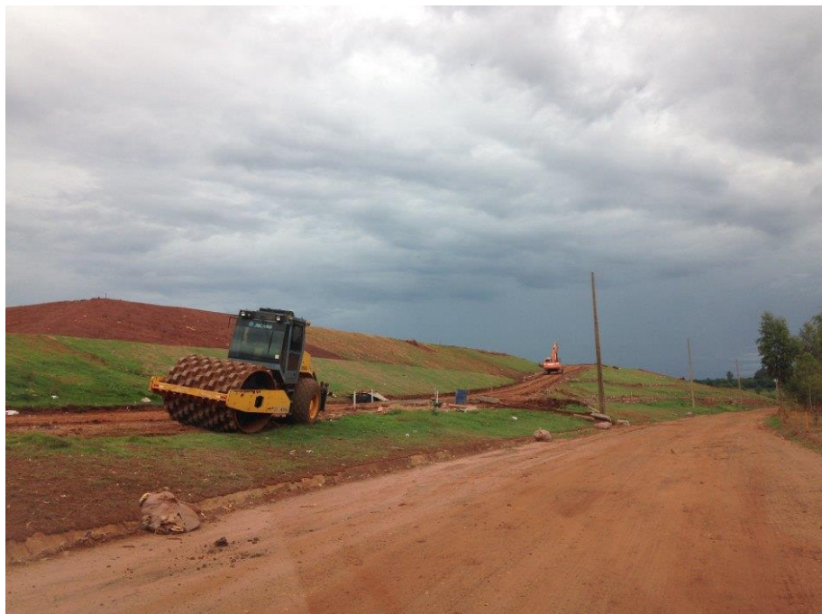
Figura 4 – Aterro Sanitário Municipal de Campo Grande. Fonte: Autor (2018).
