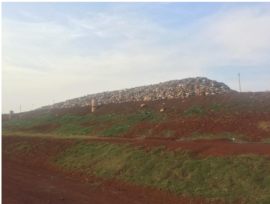
Figura 12 – Alçamento do Aterro Sanitário Municipal de Dourados. Fonte: Proprio Autor (2019).
