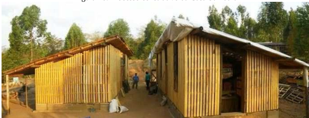
Figura 16: Processo construtivo da Casa Suindara
