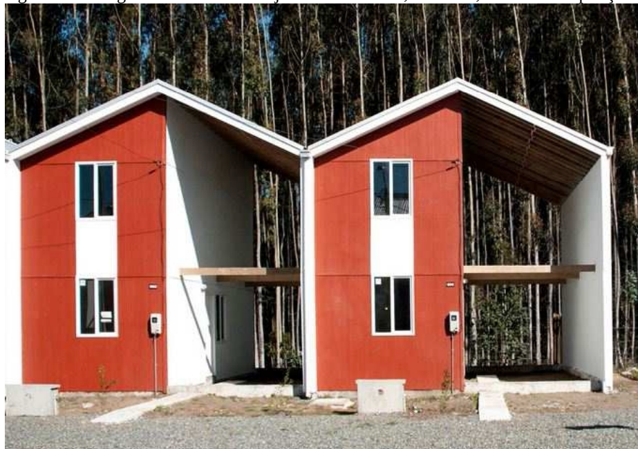
Figura 36: Fotografia das UH do conjunto Villa Verde, no Chile, antes das ampliações.
