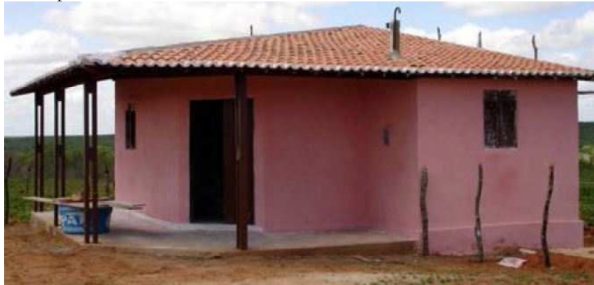
Figura 14: Moradia produzida no Assentamento Maria da Paz com assistência técnica do Grupo GERAH
