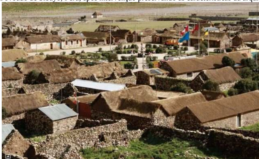
Figura 25: Povoado de Sibayo, Peru, após intervenção preservando as características da arquitetura local.
