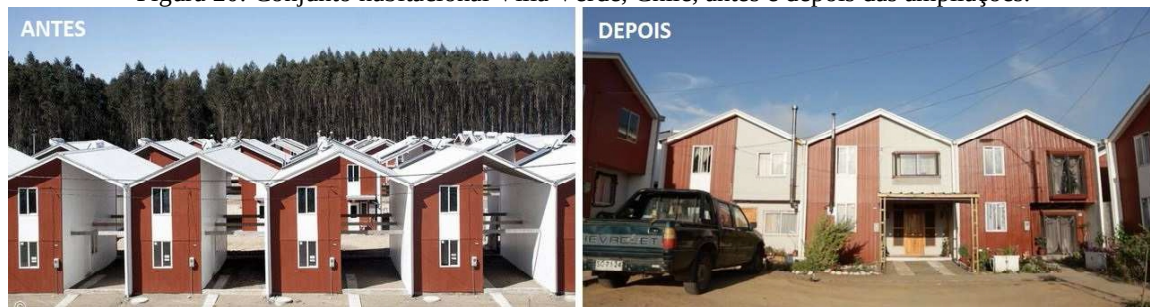
Figura 20: Conjunto habitacional Villa Verde, Chile, antes e depois das ampliações.
