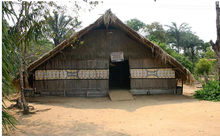
Figura 3: Maloca indígena construída com palha de carandá.
