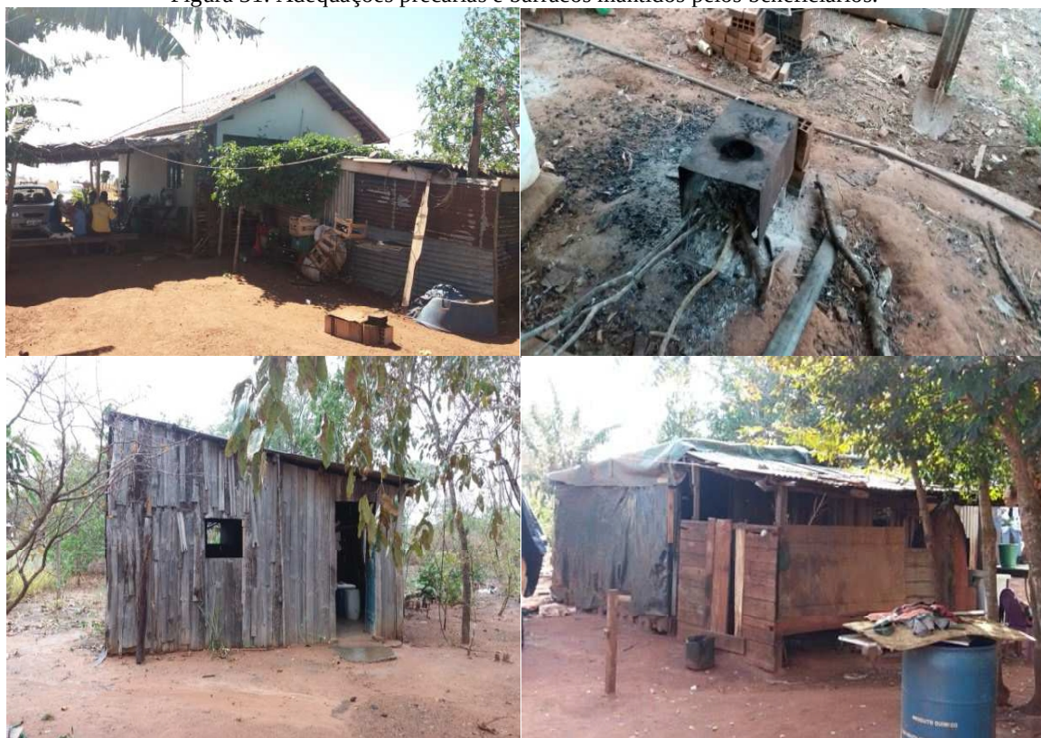
Figura 31: Adequações precárias e barracos mantidos pelos beneficiários.
