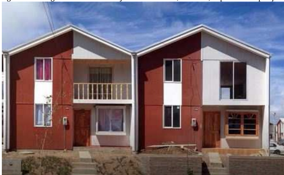
Figura 37: Fotografia das UH do conjunto Villa Verde, no Chile, depois das ampliações.
