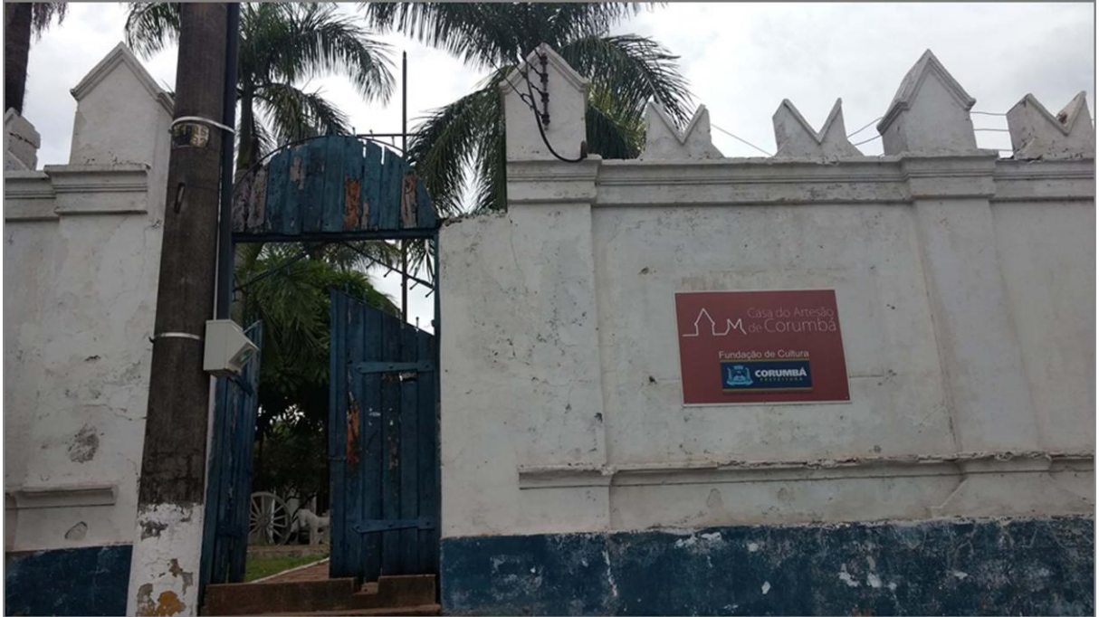
Figura 3 - Prédio do EES 1 (A).
