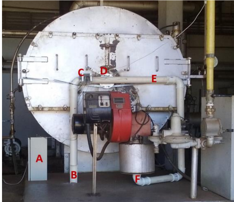
Figura 39 – identificação das partes do protótipo
