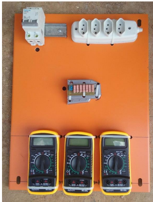
Figura 36 – carga ( R_L ), multímetros e alimentação elétrica
