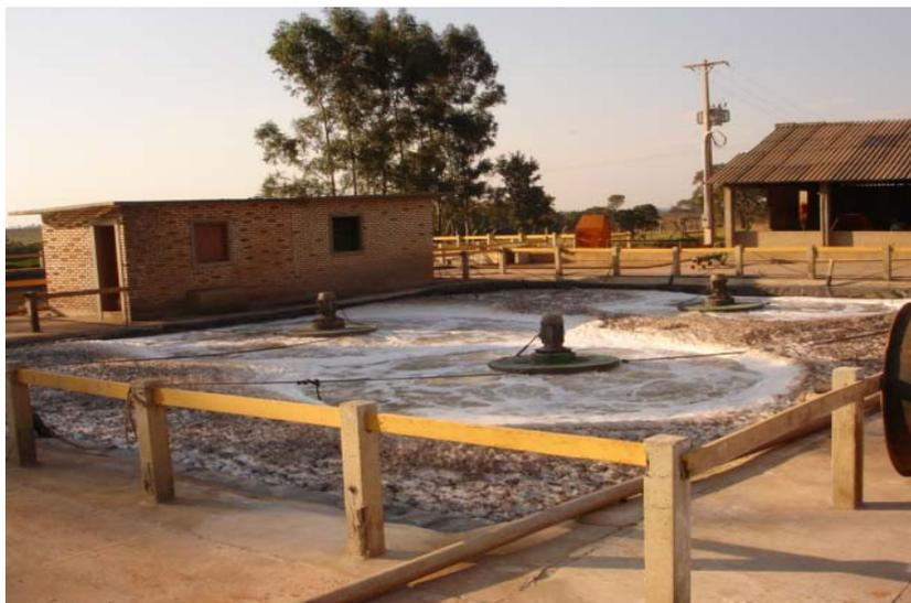
FIGURA 4.3 – Sistema primário de tratamento de efluentes.
