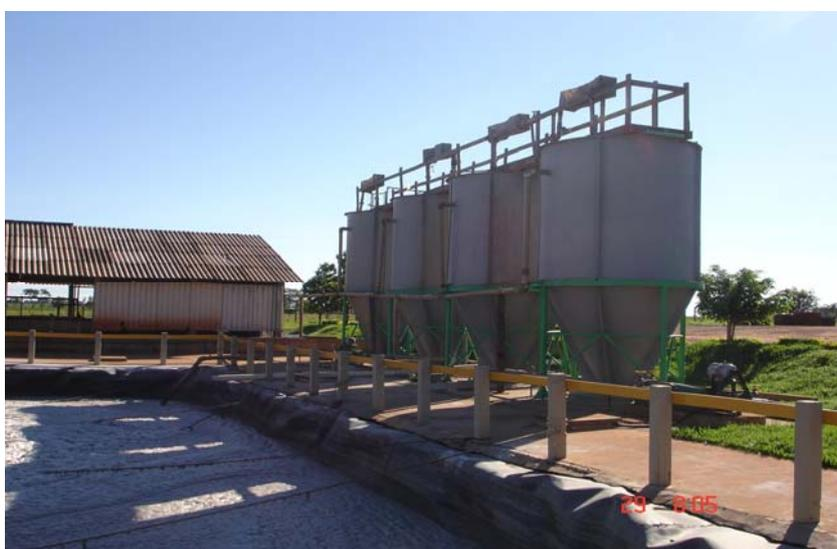
FIGURA 4.4 – Decantação primária do tratamento de efluentes.
