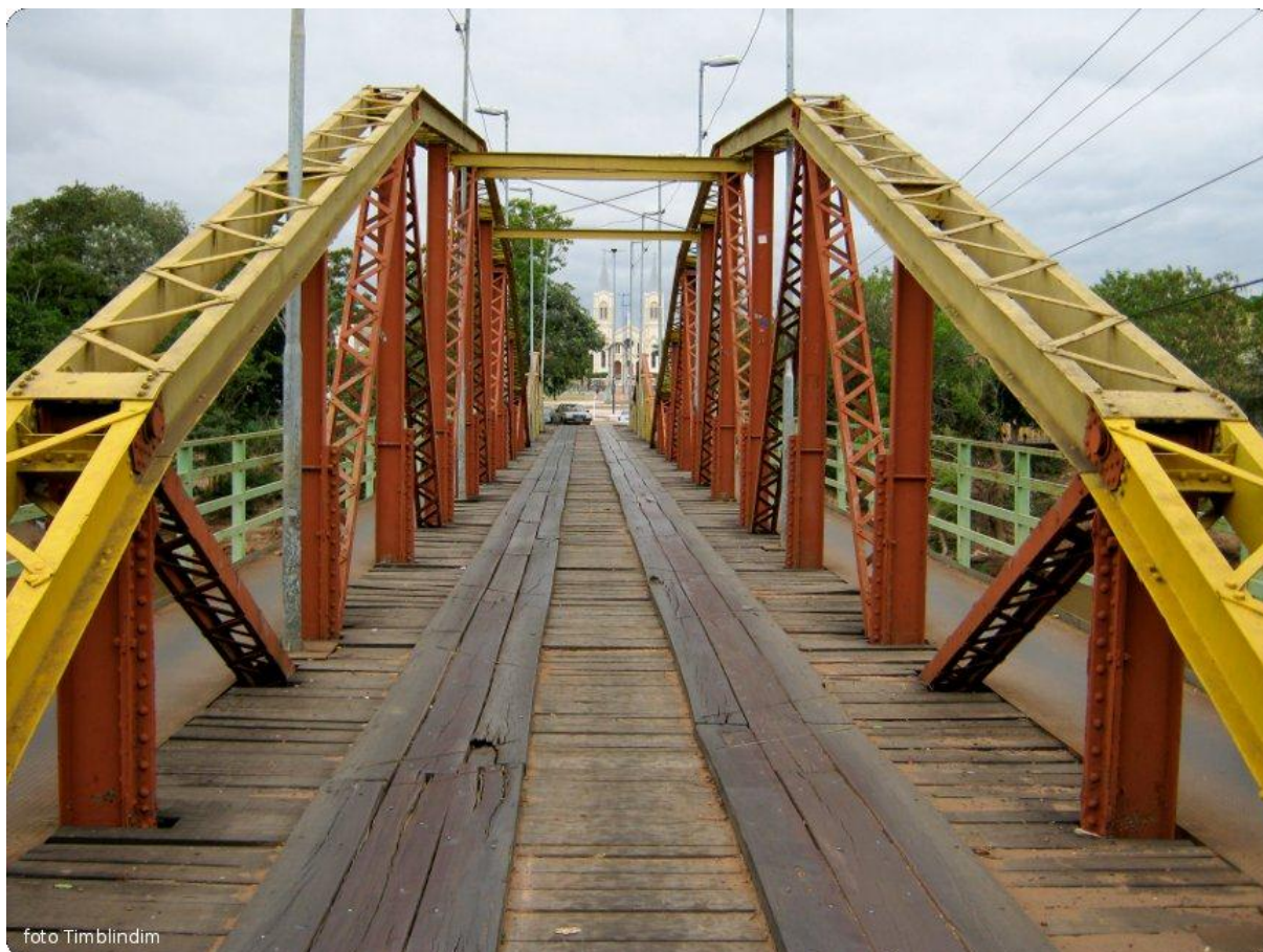
Figura 05: Aspectos da Ponte Roldão de Oliveira (Ponte Velha)
