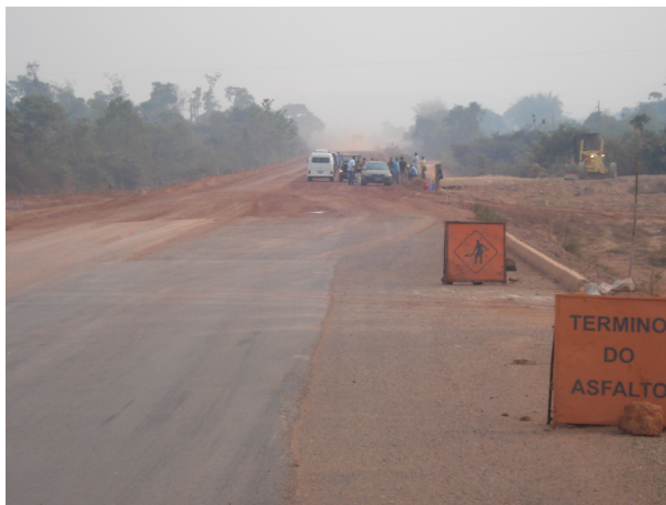
Figura 19: Trecho da BR-163 em pavimentação Fonte: Aparecido Pereira da Silva, out/2010.
