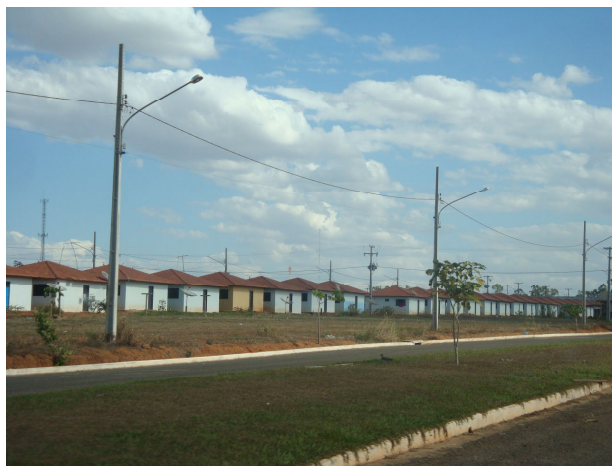
Figura 7: Casas de Funcionários da Sadia em Lucas do Rio Verde
