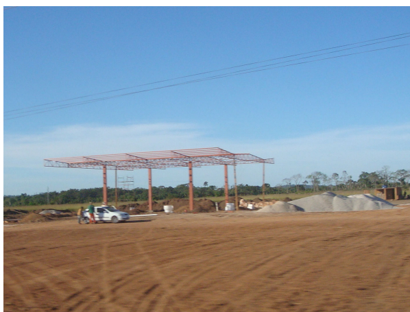
Figura 17: Posto de combustível em construção na comunidade de Cachoeira da Serra
