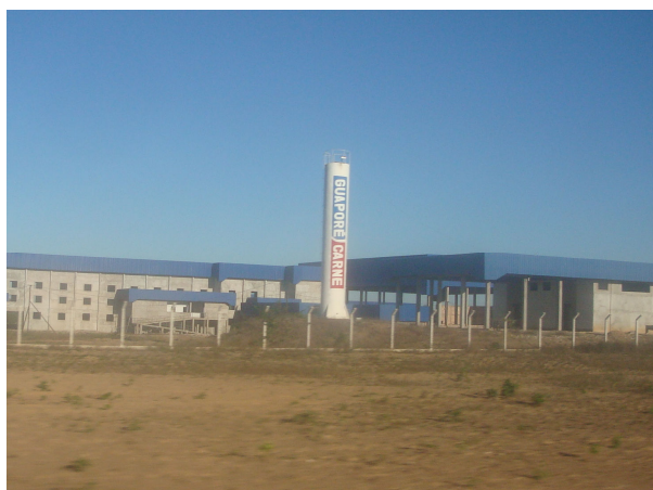
Figura 16: Frigorífico da Guaporé Carne em construção às margens da BR-163 no Pará
