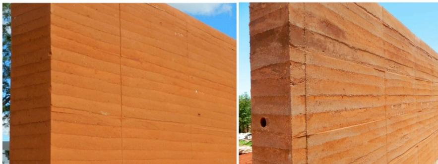
Figura 7: Parede A (esquerda) e parede B (direita), ambas com compactação pneumática
