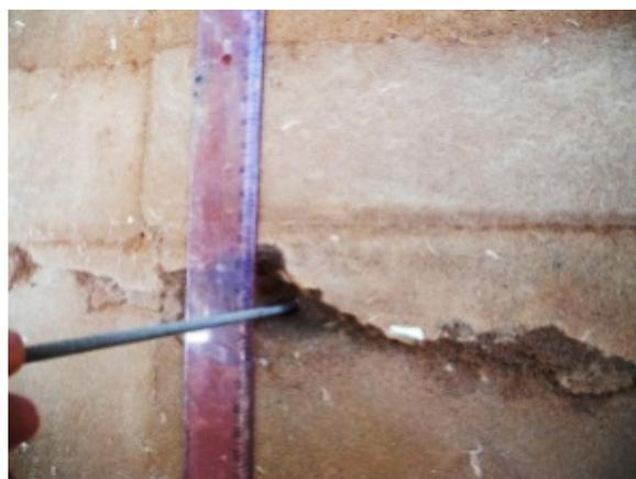
(c) método de medição da profundidade
