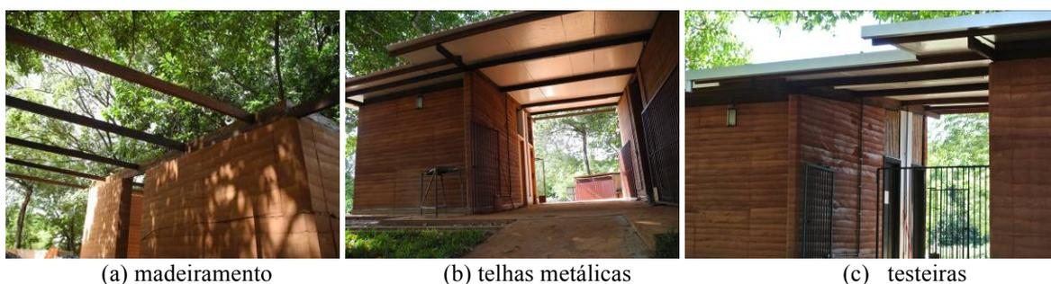
Figura 32. Cobertura metálica do protótipo de habitação.
