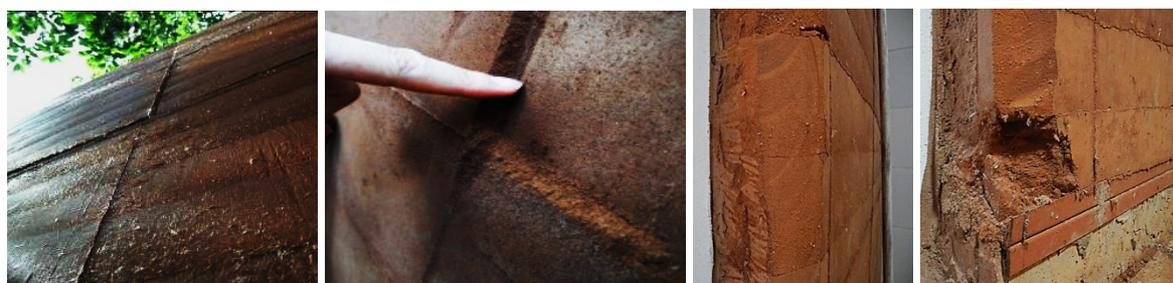
Figura 40: Marcas de cortes e defeitos de nivelamento da superfície da parede.
