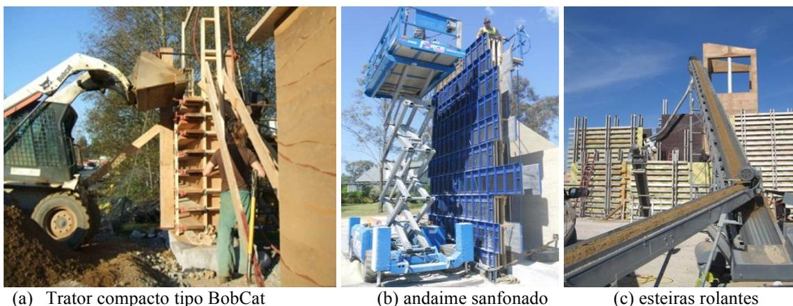
Figura 9: Equipamentos para transporte do solo
