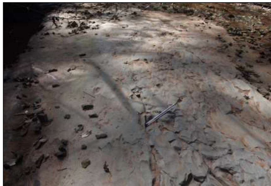
Figura 58 - Argilito do Paxixi, constituída por uma camada de mais ou menos 10m de comprimento, por 3 de largura de argilitos fraturados de coloração acinzentada. Coordenada: 202922.8 - 553600.4. Fonte: Oliveira 2016
