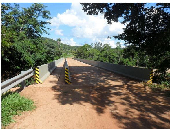
Figura 11 - Ponte sobre o Rio Aquidauana, distrito de Piraputanga
