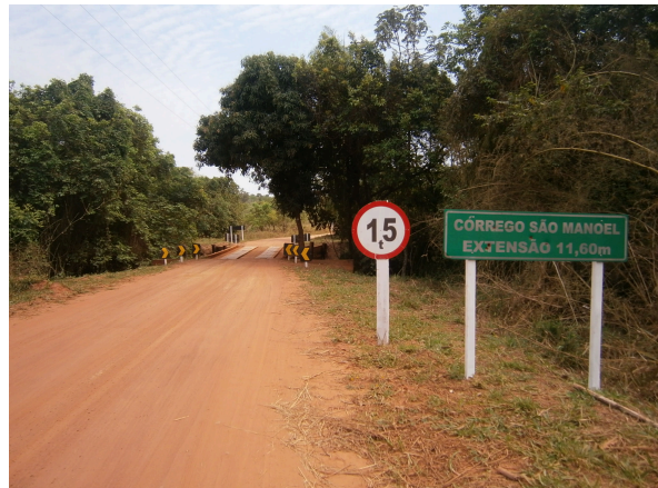
Figura 10 - Ponte sobre o córrego São Manoel MS-170
