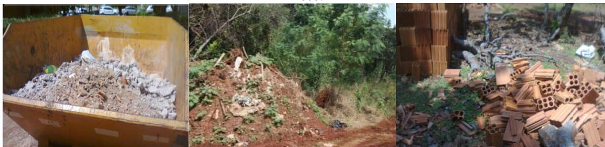
Figura 7 – Fotos da situação dos resíduos em obras no Campus de Campo Grande - verificação em visitas in loco .
