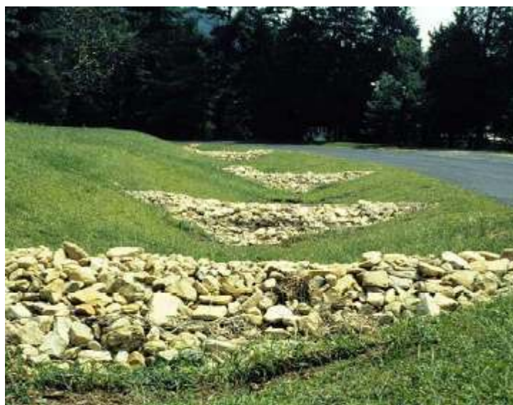
Figura 3.12: Swale gramado com subdivisões em pedras. Fonte: MPCA Stormwater manual, 2005.
