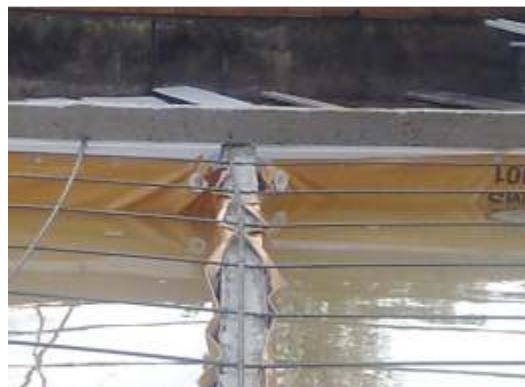
Figura 4.9: Os extravasores dos reservatórios Fonte: autora.
