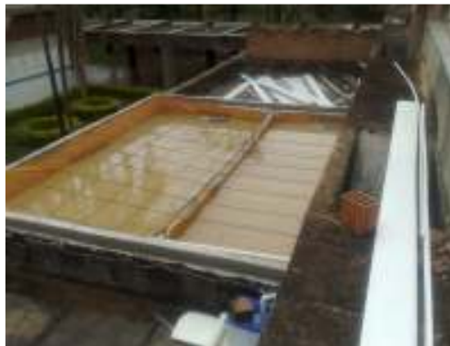
Figuras 4.6 e 4.7: Reservatório com lona em fase de montagem e após a montagem.
