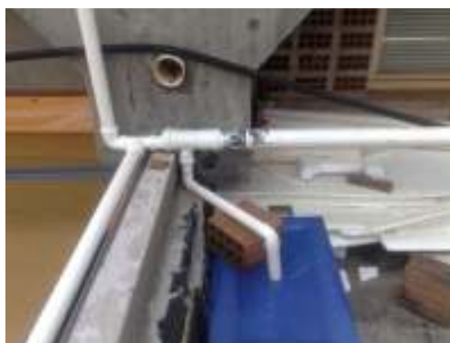
Figura 4.10: Conexões que controlam a entrada de água nos reservatórios Fonte: autora.
