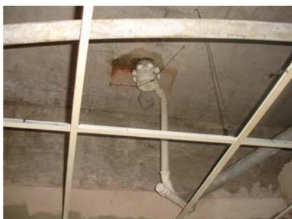
Figura 39 - Expurgo sem forro, com vazamento de água
