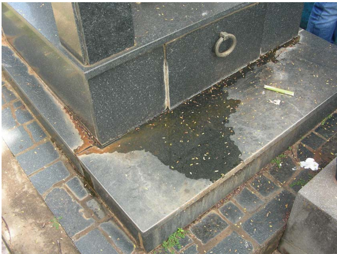
FIGURA 4.2 – Locais de escoamento de água em um túmulo no cemitério.
