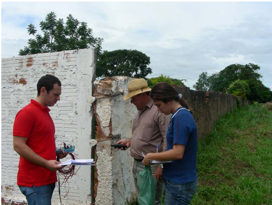
FIGURA 4.4 – Levantamento de campo: obtenção de coordenadas.
