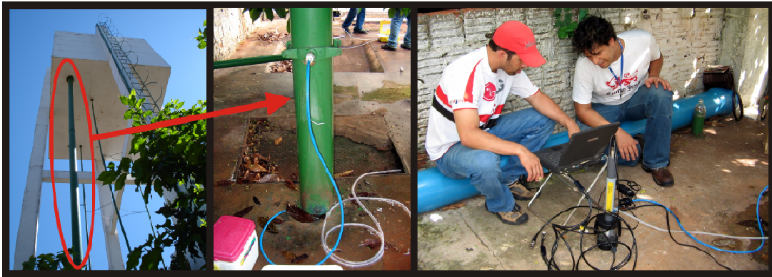
Figura 5.28 - Ponto de instalação da sonda 1 (Setor B).
