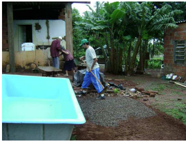
Construção do wetland de fluxo horizontal subsuperficial (CW-FH).
