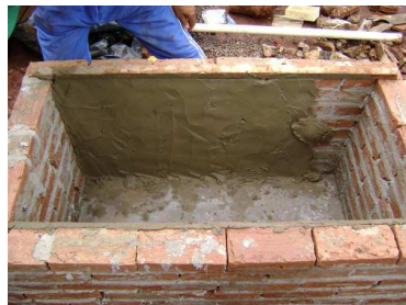
Construção do Tanque de Sedimentação – impermeabilização.
