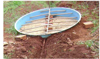
Construção e preenchimento do wetland de fluxo vertical (CW-FV).
