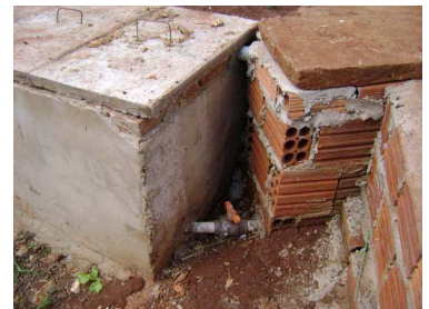
Construção do Tanque de Sedimentação – impermeabilização.
