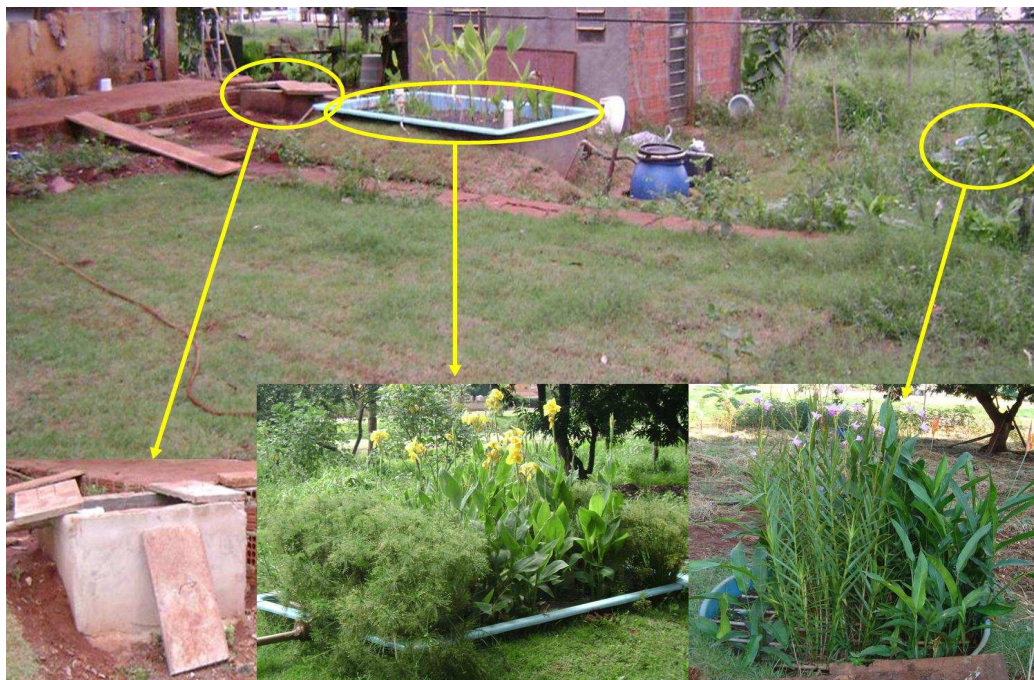
Sistema híbrido de wetlands construídas, Campo Grande, MS, Brasil.
