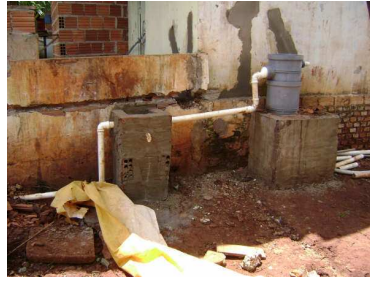
Construção do suporte para a caixa de gordura e da caixa de passagem/inspeção.
