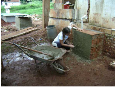
Construção do suporte para a caixa de gordura e da caixa de passagem/inspeção.
