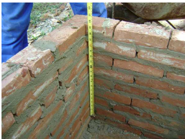
Construção do Tanque de Sedimentação – impermeabilização.
