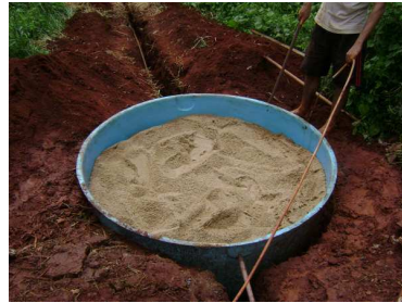
Construção e preenchimento do wetland de fluxo vertical (CW-FV).
