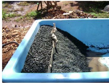
Construção do wetland de fluxo horizontal subsuperficial (CW-FH).
