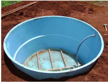
Construção e preenchimento do wetland de fluxo vertical (CW-FV).
