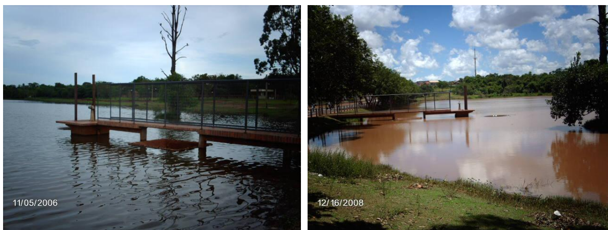
Figura 06: Fotos do deck na região limnética do Lago do Amor, próximo à barragem, após as obras de revitalização do lago e a construção de um segundo sumidouro de escape. Fotos: Priscila Alonso Oliveira.
