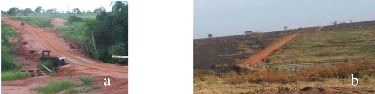
**Fig.22** – P.A. Tejin, Nova Andradina, MS: a) Estrada atravessa perpendicularmente o córrego, e o escoamento superficial drena para o seu leito; b) Longos trechos de estrada em aclive cortam perpendicularmente um açude, no P.A. Avaré, Santa Rita do Rio Pardo, MS:
