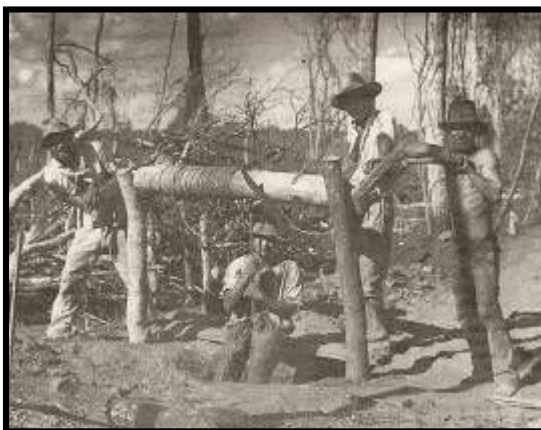
Figura 4 – Perfuração do poço. Fonte: YUBA, 1993, p. 40.
