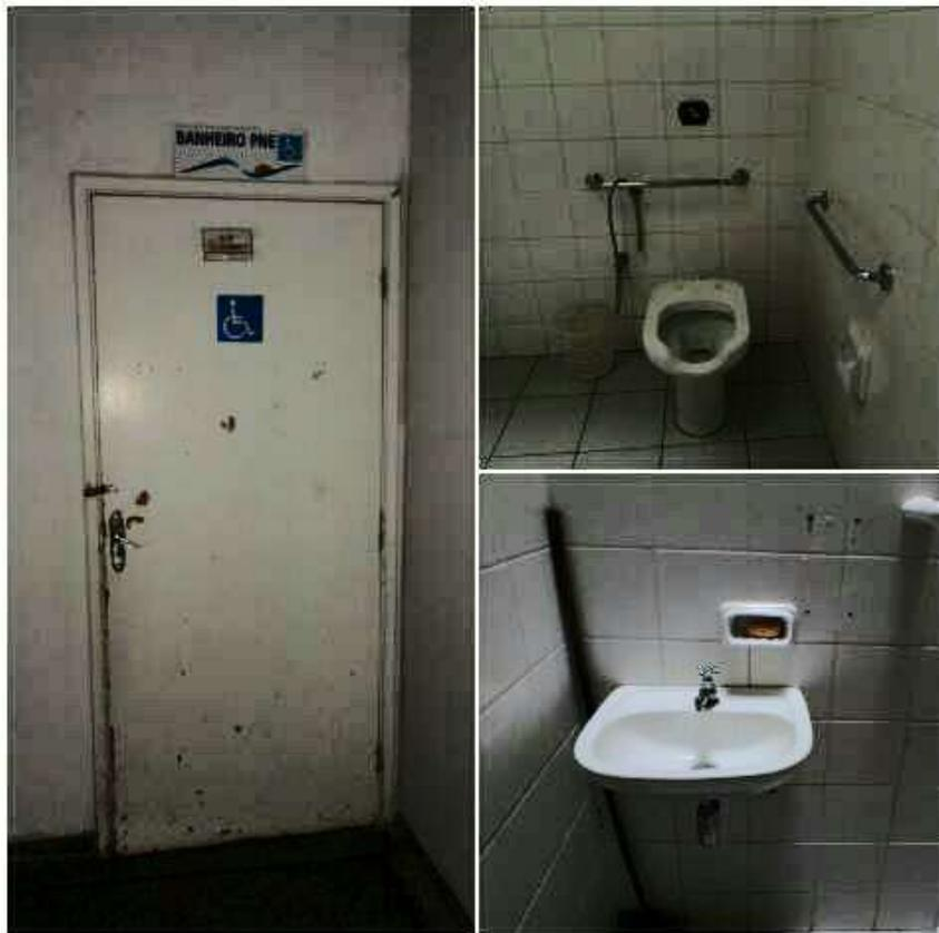
*Figura 4 – Banheiro PNE sem descarga e torneira adaptadas*
