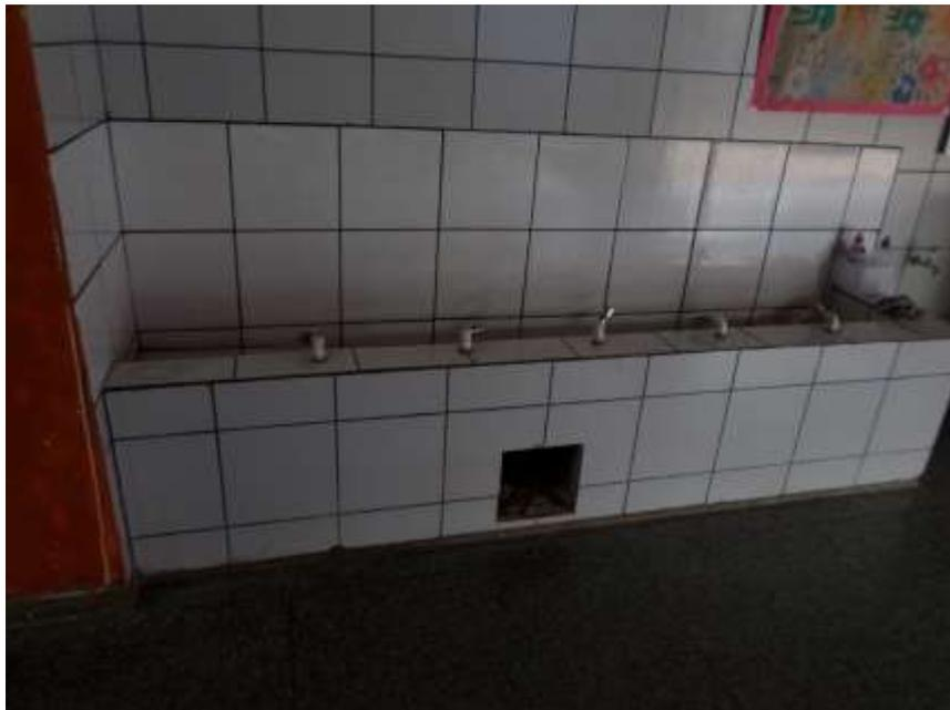
*Figura 6 – Bebedouro com torneiras ao alcance de um usuário de cadeira de rodas*
