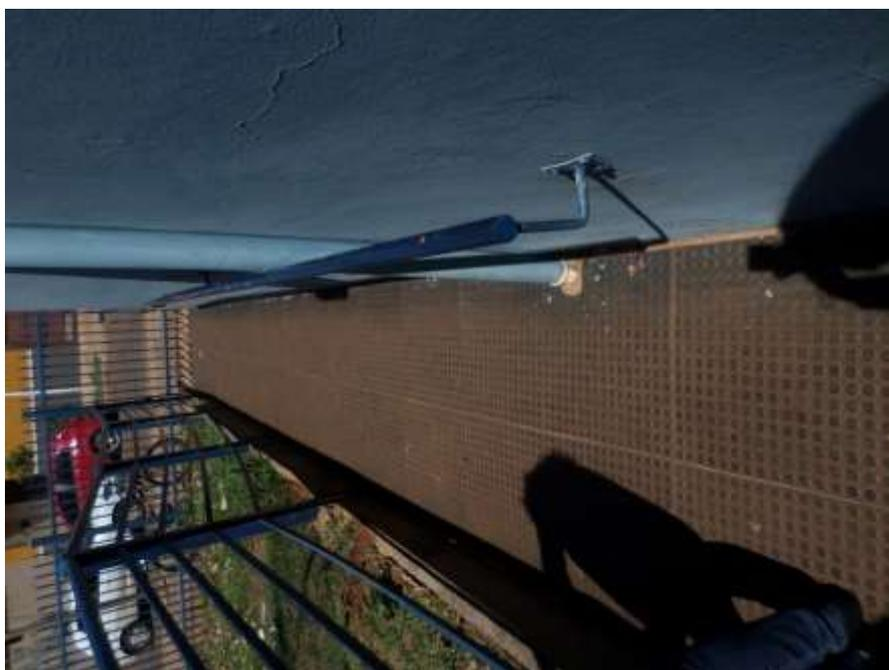
*Figura 20 – rampa lateral, coberta com tapete tátil emborrachado*
