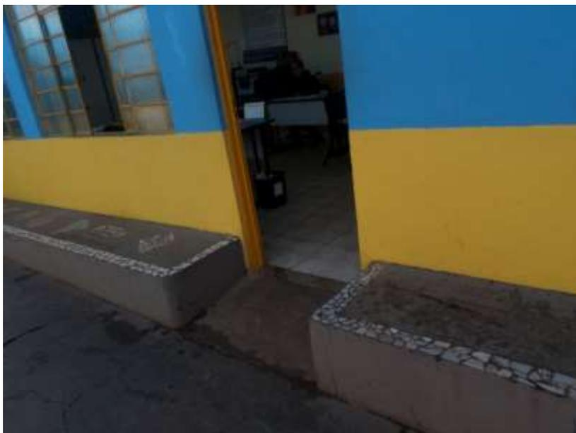
*Figura 13 – Acesso à sala de aula: entrada rebaixada, mas ladeada por bancos de cimento*
