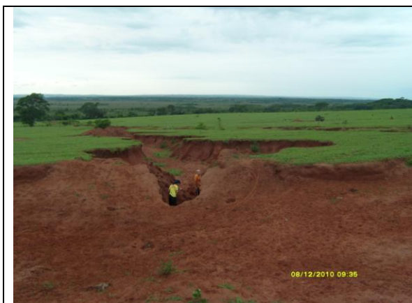
Figura 61 – Voçoroca no final da área agricultável da bacia, na divisa da reserva Cisalpina, com aproximadamente 300 m de extensão
