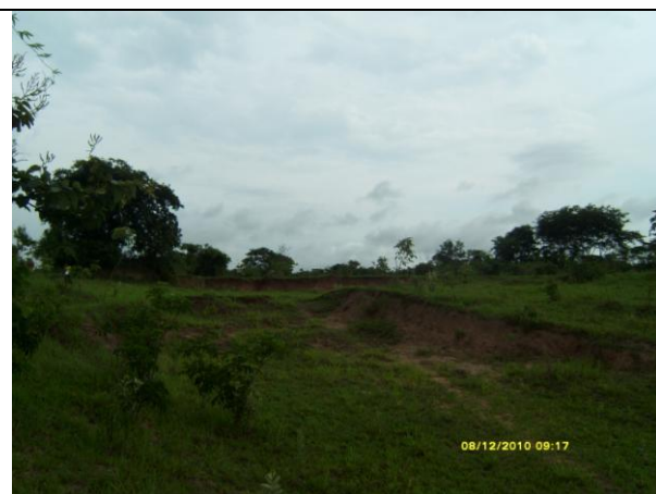
Figura 50 – Caixa de empréstimo da estrada rural que liga o assentamento Pedra Bonita à Brasilândia
