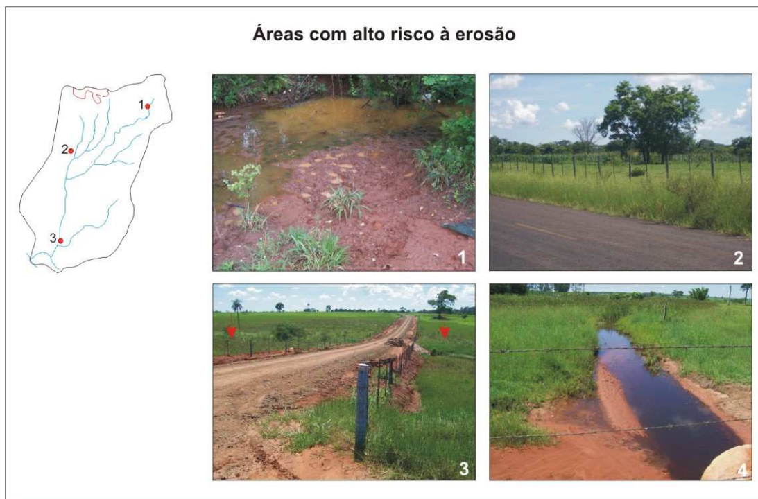
Figura 22: Áreas com alto risco à erosão. Autora: Laís Coelho do Nascimento Silva.
