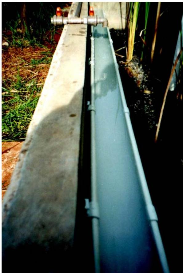
Figura 4.2 - Estruturas de entrada (canaleta de distribuição).
