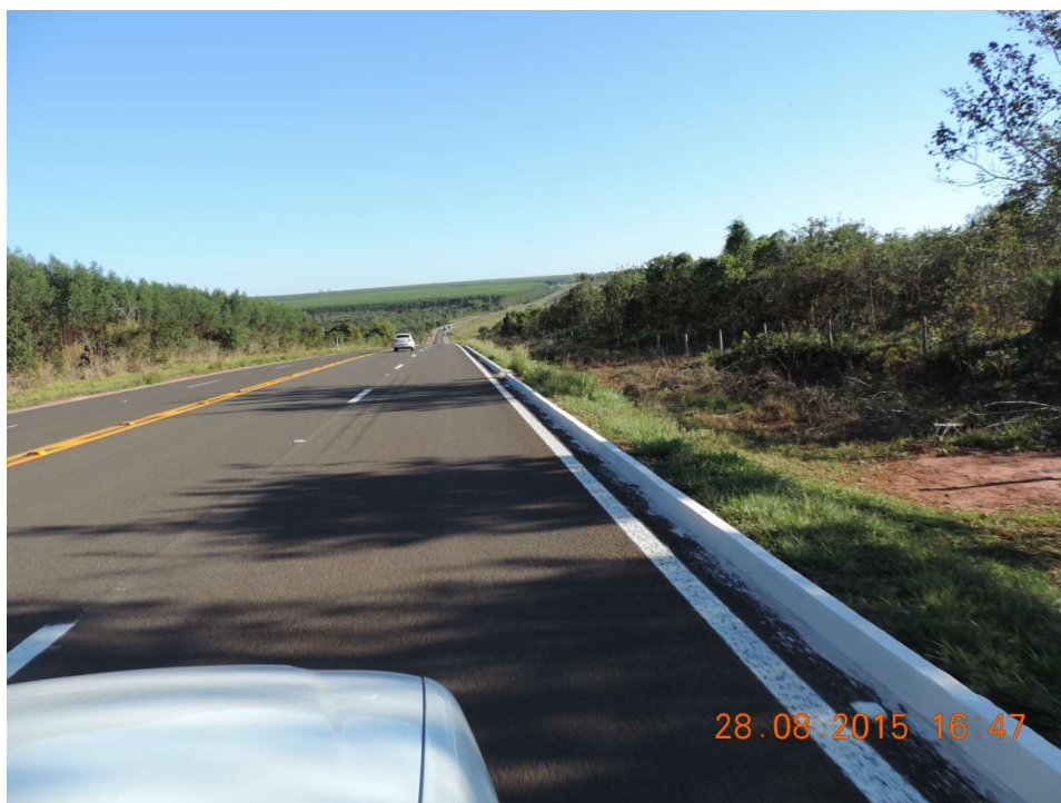
Figura 23: Área Com Declive Acentuado cuja Classe de Energia Potencial Erosiva do Relevo se encontra entre Suavemente Média e Moderadamente Média.
