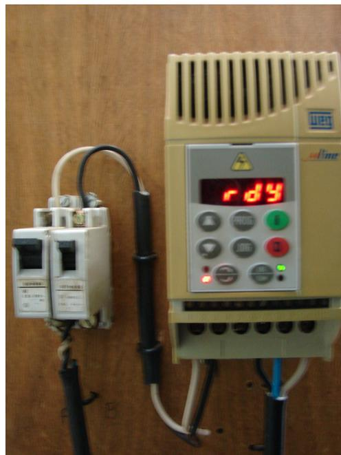
**Figura 4.2.** Inversor de frequência para controle de precisão do sistema de bombeamento.
