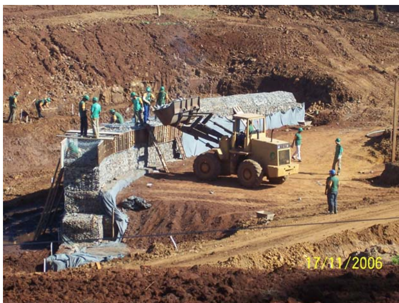
Foto 2– Construção do lago para desassorear o Lago Maior do Parque das Nações Indígenas (17/11/2006).
