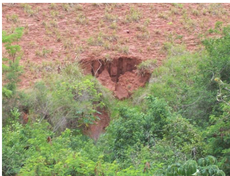
Foto 5 – Taludes sofrendo processo erosivo nas cabeceiras do Córrego Sóter (28/10/2006).
