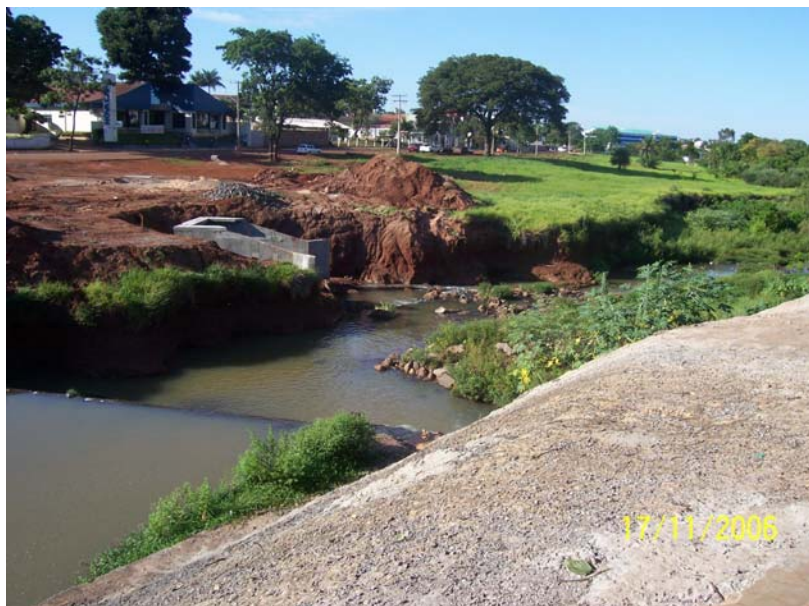
Fotos 3— Obra de manejo de águas pluviais nas proximidades do Shopping Campo Grande . Dissipador de energia tipo impacto (17/11/2006).
