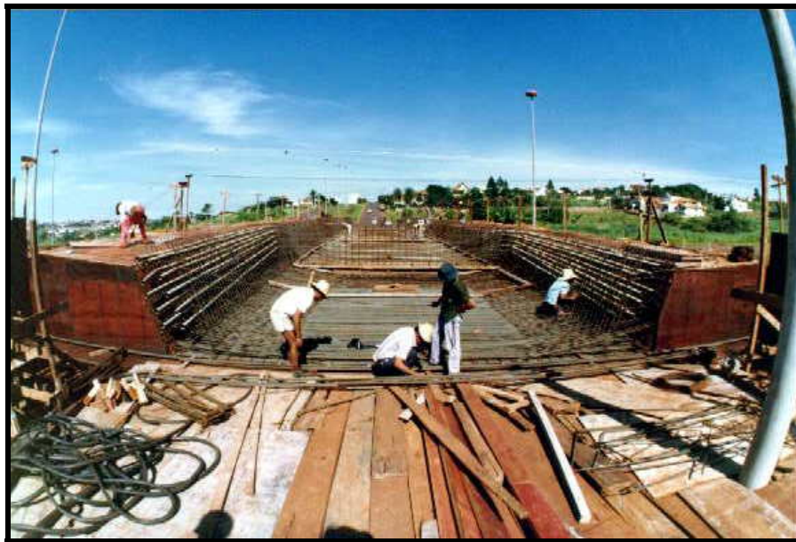
Figura 5: Construção do Viaduto sobre a Av. Afonso Pena – 1983 (Avedis Balabanian).
