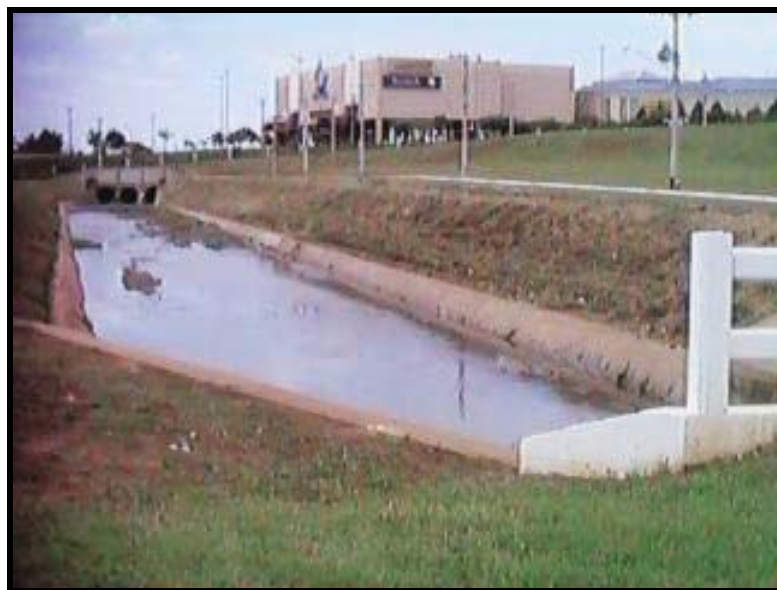
Figura 11: Canalização do córrego Prosa – 2001.
