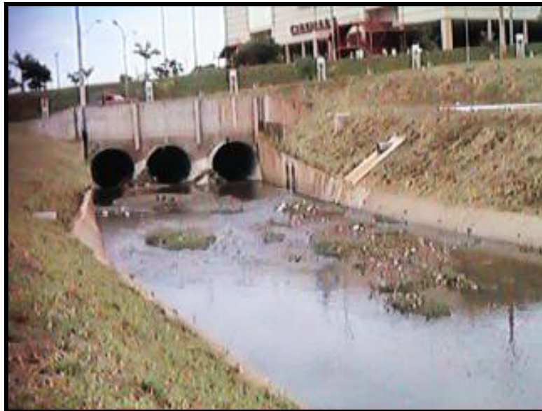
Figura 19: Bueiro triplo tubular metálico implantado no sistema viário Complexo Prosa III - córrego Prosa - 2001.
