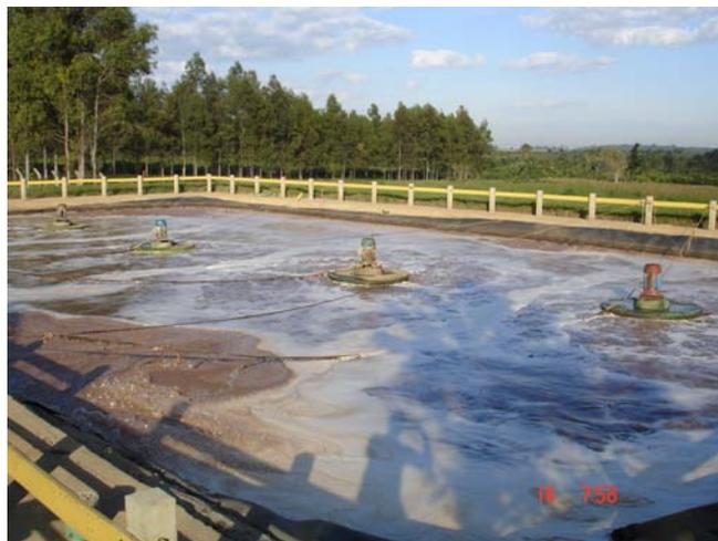
FIGURA 4.5 – Reator lodo ativado.
