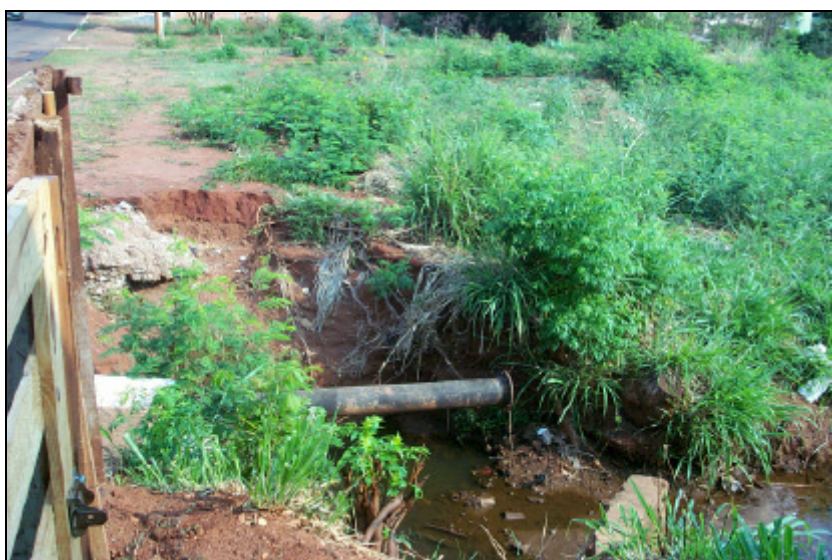
Figura 6: Área aterrada na margem do córrego Cabaça, que acaba por sofrer solapamento nos períodos de chuvas fortes (junho, 2002).
