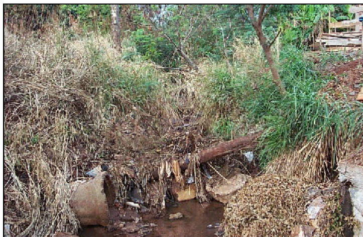
Figura 53: Entulhos bloqueiam o curso normal do córrego Cabaça, causando represamento (junho, 2002).
