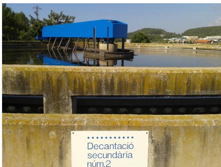
Figura 6. Ilustração do tanque de decantação secundária da estação de tratamento de esgoto Gavá-Viladecans na Espanha.
