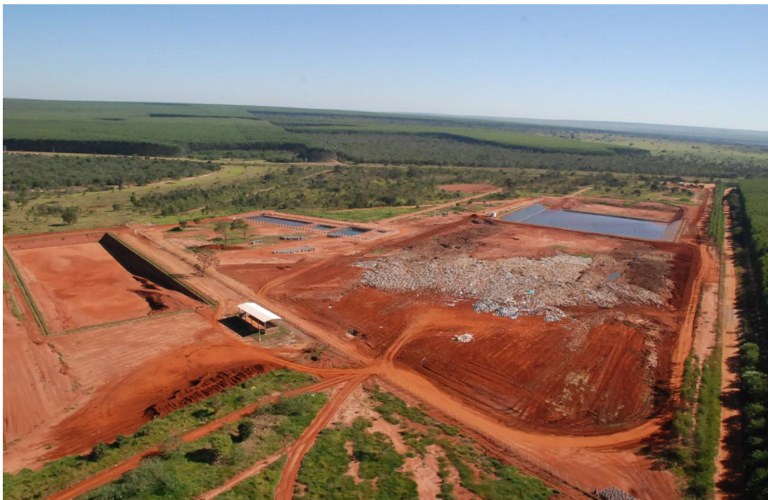
Figura 5: Aterro sanitário de Três Lagoas, MS.
