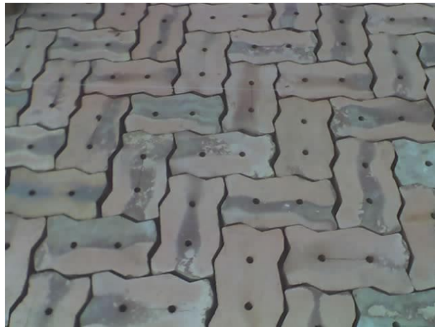
Figura 36: Bloco Ecológico inter-travado após desenforma.
