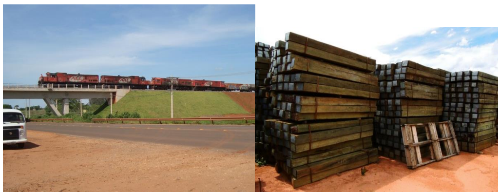
Figura 26: Construção do contorno ferroviário em Três Lagoas/MS
