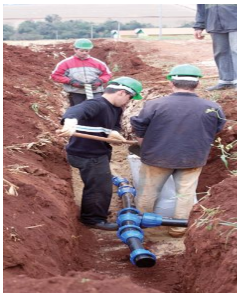
Figura 49- Instalação dos dutos
