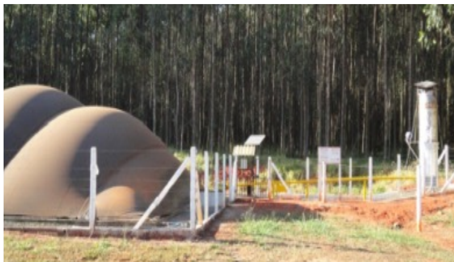
Figura 45 - Biodigestor e flare da UPL COOASGO.
