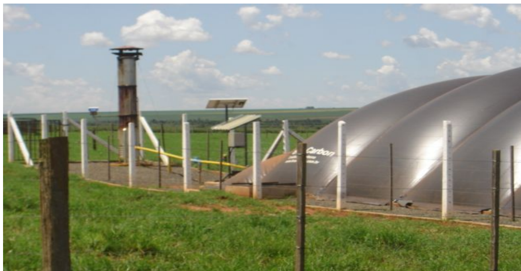
Figura 3 - Biodigestor em uma suinocultura em São Gabriel do Oeste.
