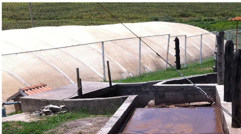
Figura 38 - Biodigestor de resíduos bovinos.
