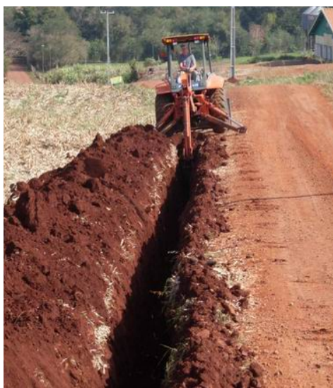
Figura 48 - Escavação de Sulcos.
