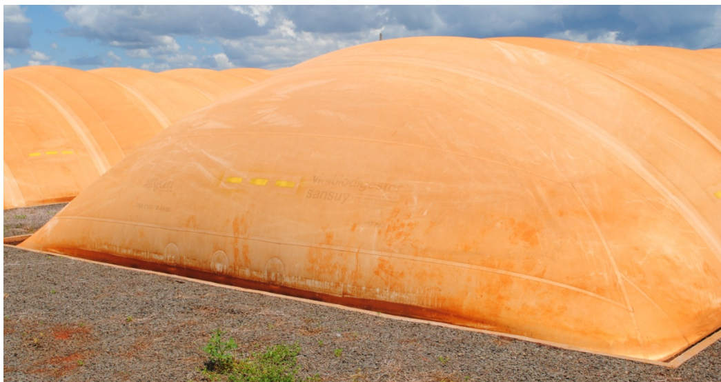
Figura 34 - Biodigestor com membrana.
