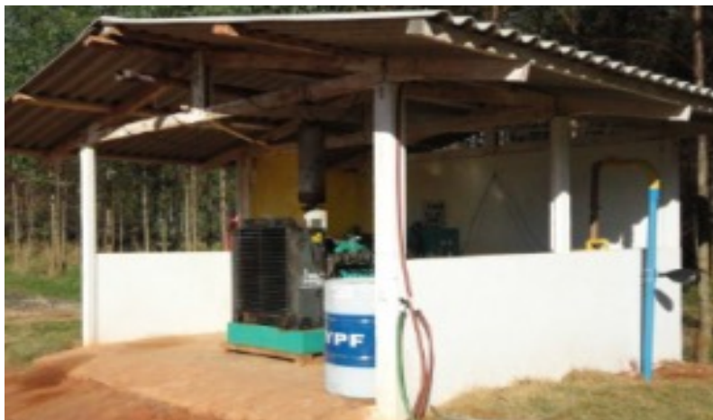
Figura 46 - Motor a biogás da UPL COOASGO.
