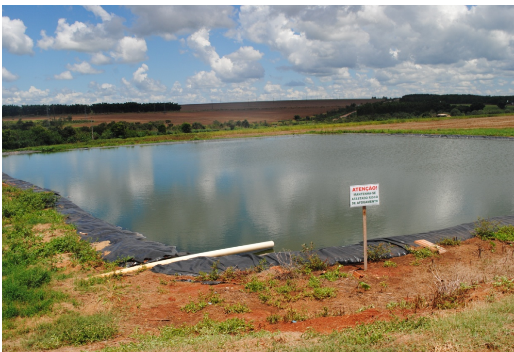
Figura 33 - Lagoa de decantação.
