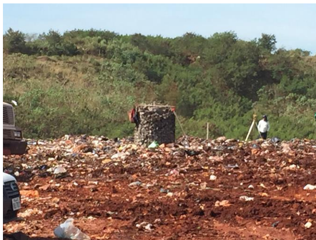
Figura 44 - Dreno vertical de Biogás revestido com brita e tela.
