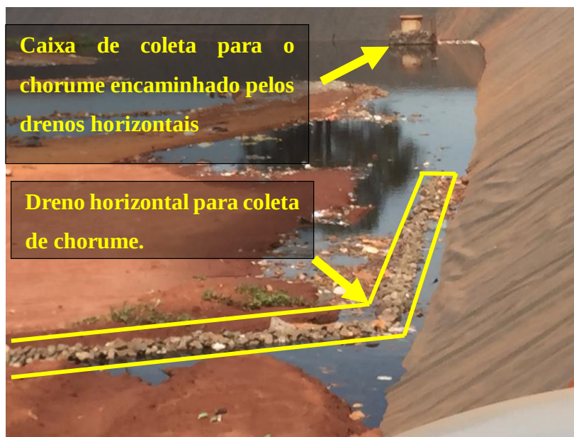
Figura 35 - Aterro Dom Antônio Barbosa II evidenciando dreno horizontal e caixa de coleta de chorume.
