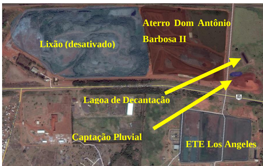
Figura 27 - Vista aérea do aterro Dom Antônio Barbosa II e adjacências.
