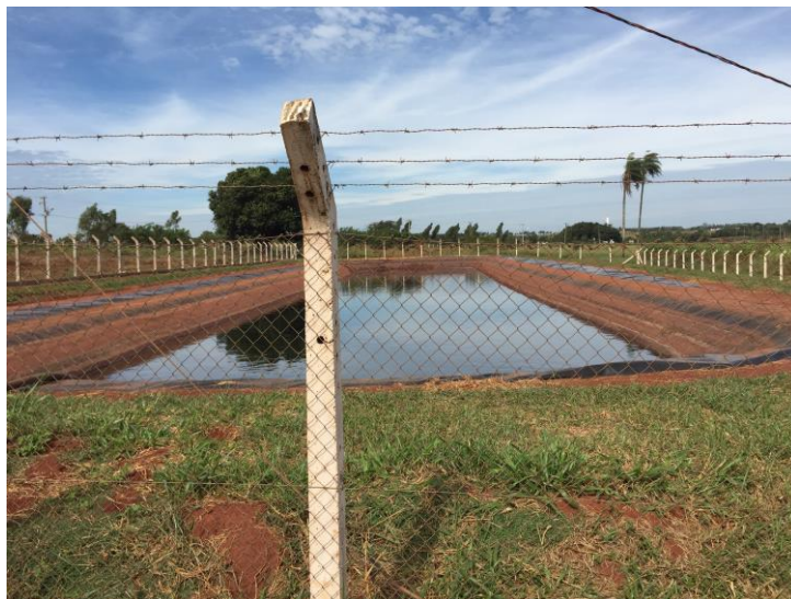
Figura 39 - Vista frontal da lagoa de decantação.
