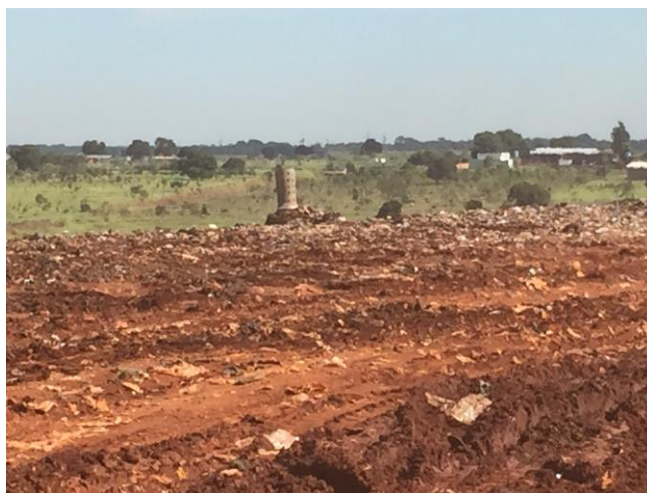
Figura 43 - Dreno vertical de Biogás em fase de implantação em nova camada de aterro.
