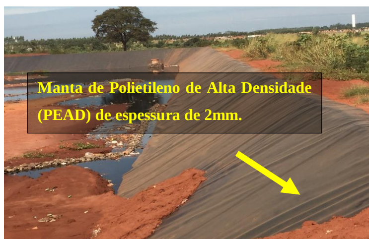
Figura 33 - Aterro Dom Antônio Barbosa II evidenciando manta de PEAD (detalhe).
