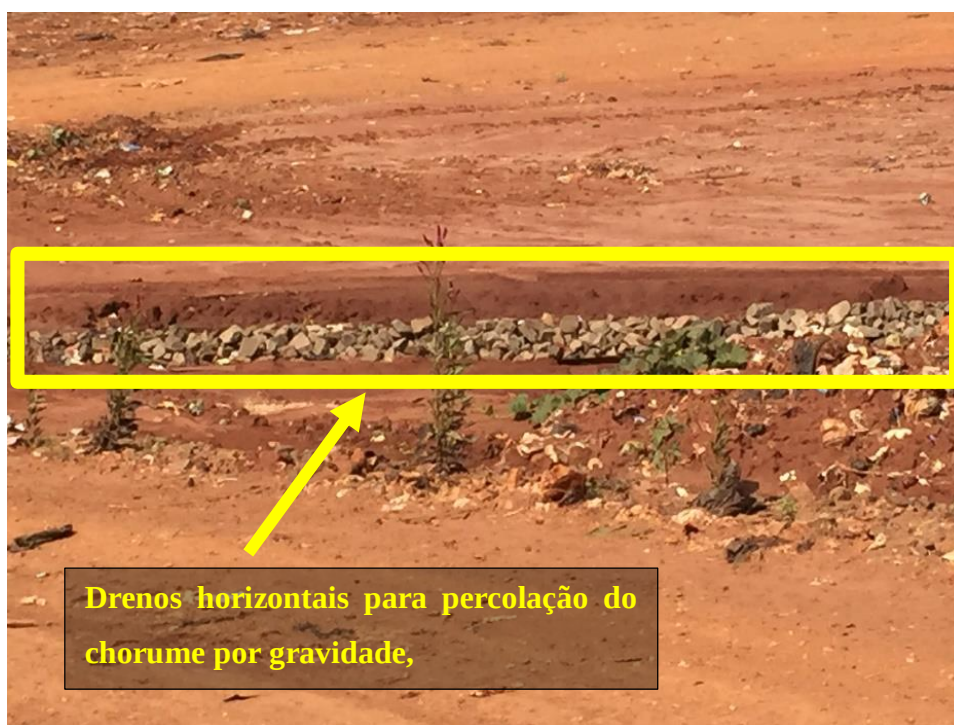
Figura 34 – Aterro Dom Antônio Barbosa II evidenciando dreno horizontal.
