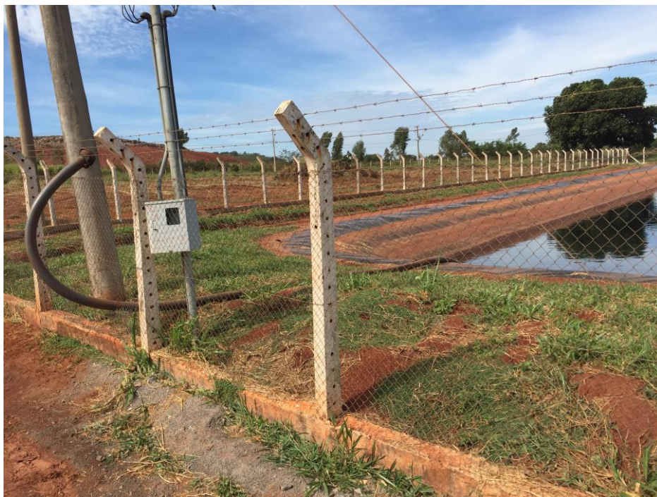
Figura 38 - Lagoa de Decantação.
