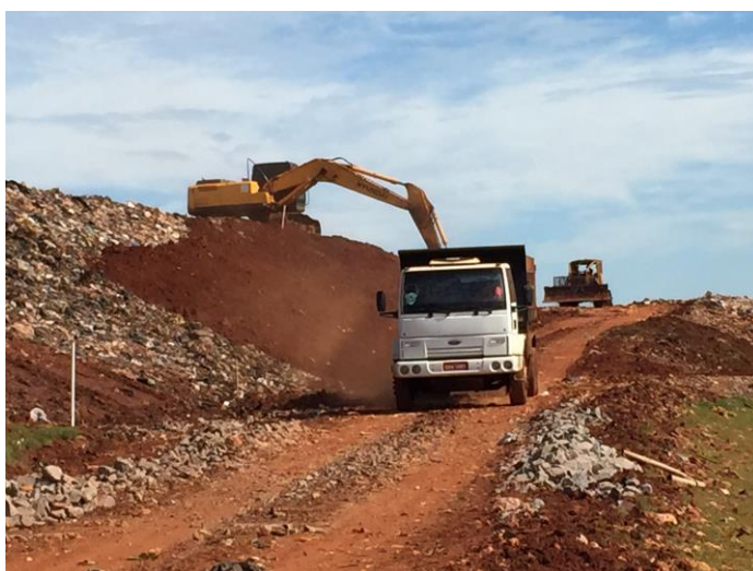
Figura 41 - Preparação do talude para o posterior recebimento de cobertura vegetal.
