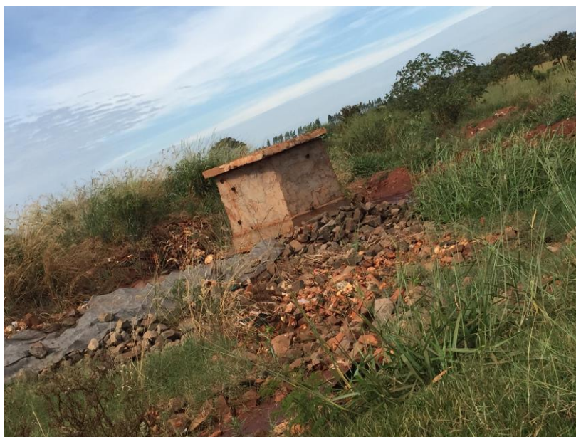
Figura 36 - Caixa de passagem do percolado captado.
