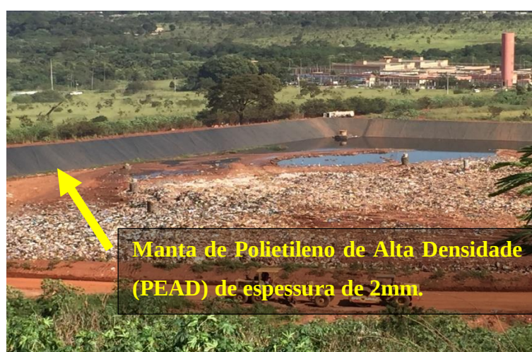
Figura 32 - Aterro Dom Antônio Barbosa II evidenciando manta de PEAD.
