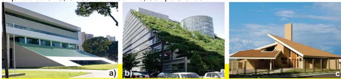
FIGURA 22 – O plano inclinado e suas sugestões: a) Plano inclinado na CAC; b) Teto jardim inclinado, Edifício ACROS, Fukuoka; c) Telhado da Casa Toniasso de autoria do mesmo arquiteto da CAC, Gil Carlos de Camillo, Campo Grande.
