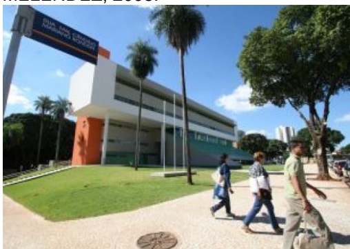
FIGURA 02 – Fotografia vista do acesso principal da CAC, 2008. Fonte: http://oabms.org.br/noticias/ver/4548/advoga-do-homenageado-em-obra-inaugurada-na-capital.html%5D .
