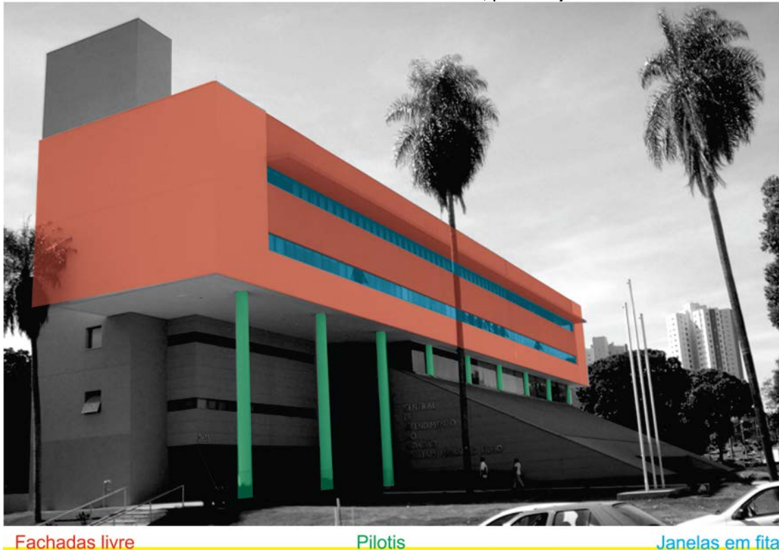
FIGURA 20 – Símbolos modernistas na CAC: fachada livre, pilotis e janela em fita.
