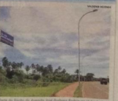
Parte do trecho da Avenida José Barbosa Rodrigues já foi furtado
