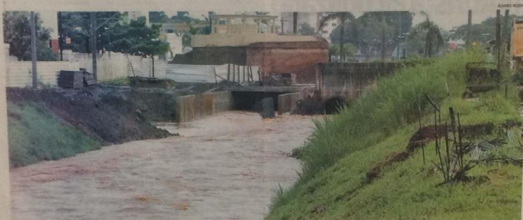
A prefeitura de Campo Grande tem que tentar amenizar a situação com obras de contenção de enchentes e de canalização, porém, essas soluções têm se mostrado cada vez menos eficientes diante das chuvas.
