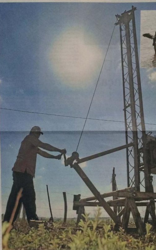
Dureza, de sol a sol. Com sonda de ferro improvisada, Denivaldo Barcelos trabalha na perfuração de um poço d'água em seu lote
