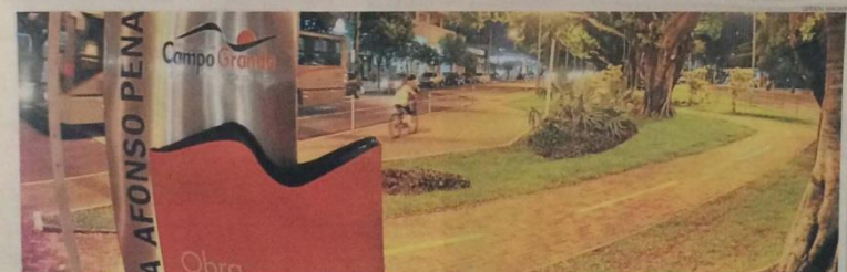
19h41min - Em vez de usar a ciclovia, a ciclista (à esquerda) passa pela calçada lateral da Avenida Afonso Pena, que serve de estacionamento dominical. Obra custou R$ 147 mil do PAC Mobilidade Urbana
