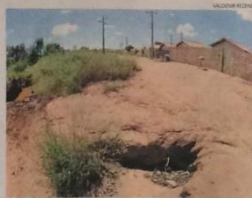
Descaso. Buraco toma conta de rua de acesso ao conjunto Serraville
