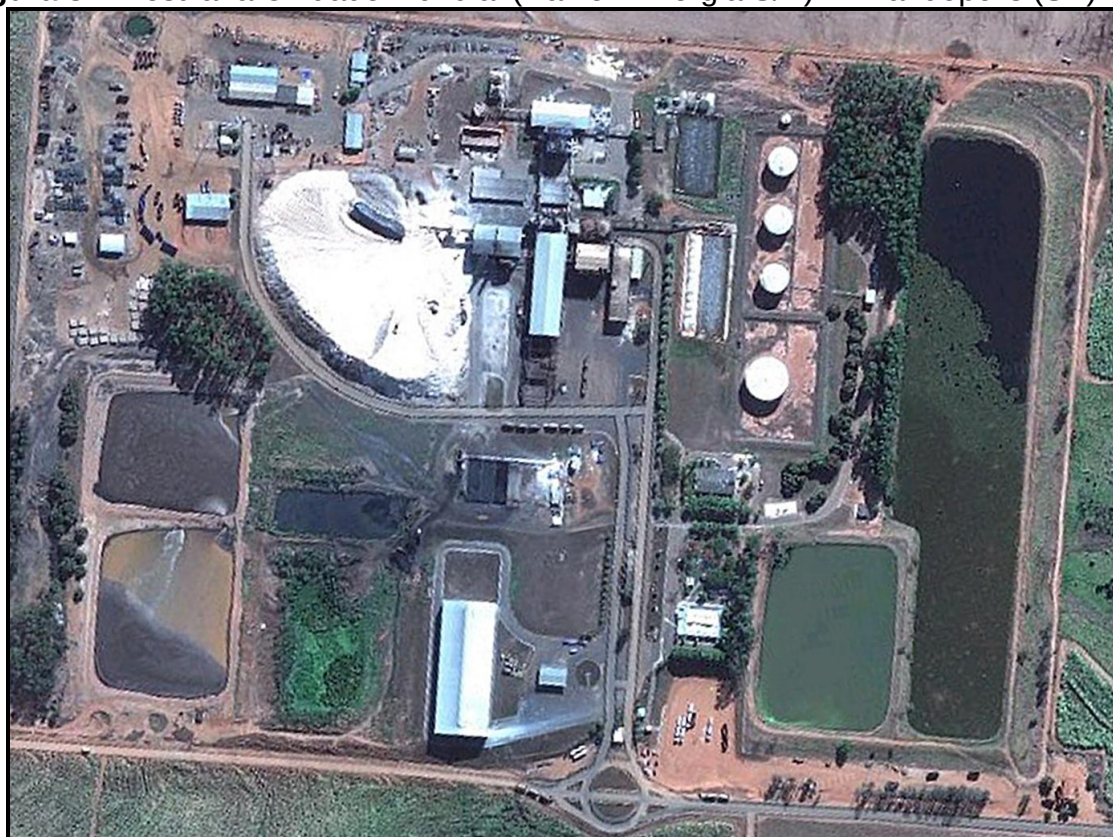
Figura 8 – Destilaria Unidade Mundial (Raízen Energia S/A) - Mirandópolis (SP)
