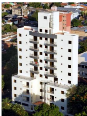
Figura 4.12 - Fachada Edifício Fortaleza III.
