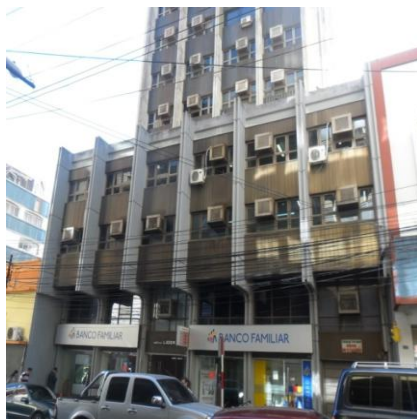
Figura 3.7 - Fachada Edifício Líder IV
