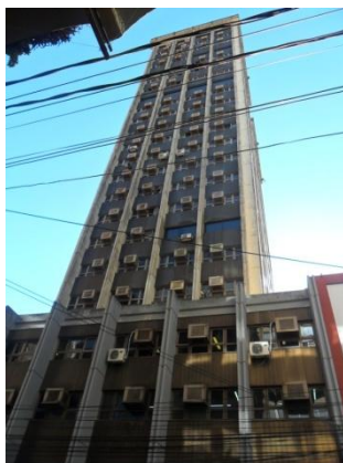
Figura 3.6 - Fachada principal Edifício Líder IV
