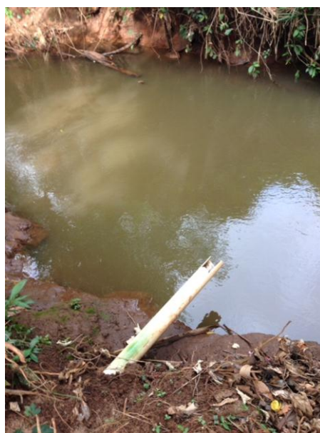
Figura 7.15 - Lançamento efluente no córrego receptor
