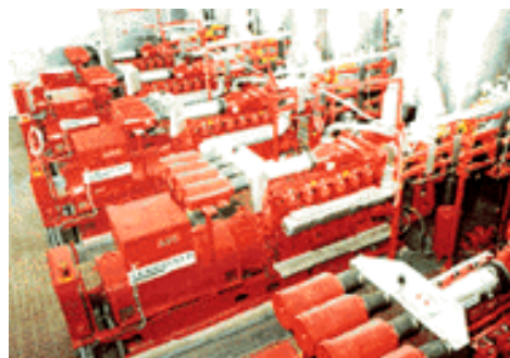
Figura 5.1 - Motores Ciclo Otto para biogás
