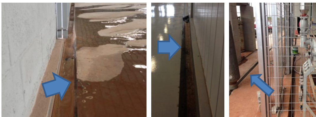
Figura 7.7 - Canaletas de captação do Efluente
