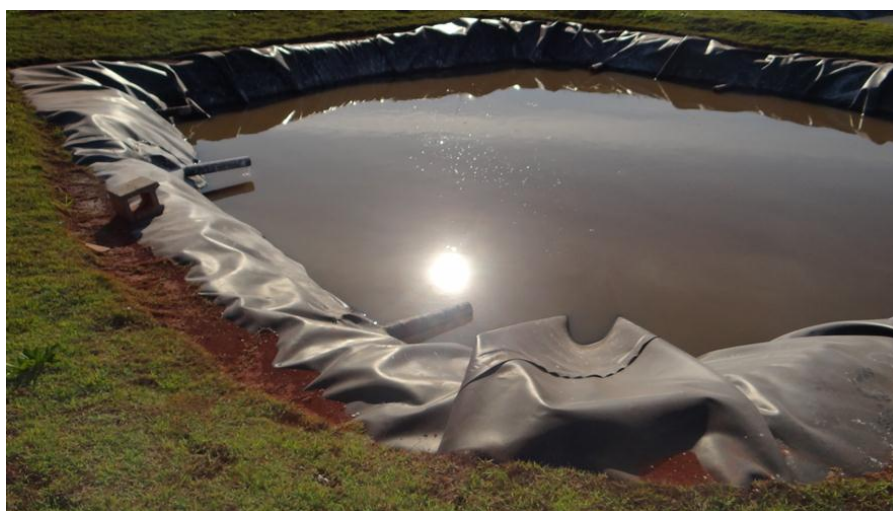
Figura 7.13 - Imagem Lagoa Anaeróbia
