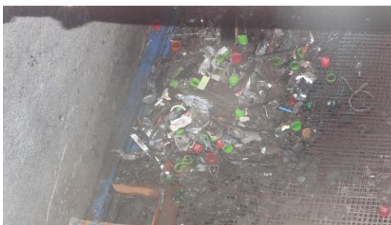
Figura 7.8 - Gradeamento primário
