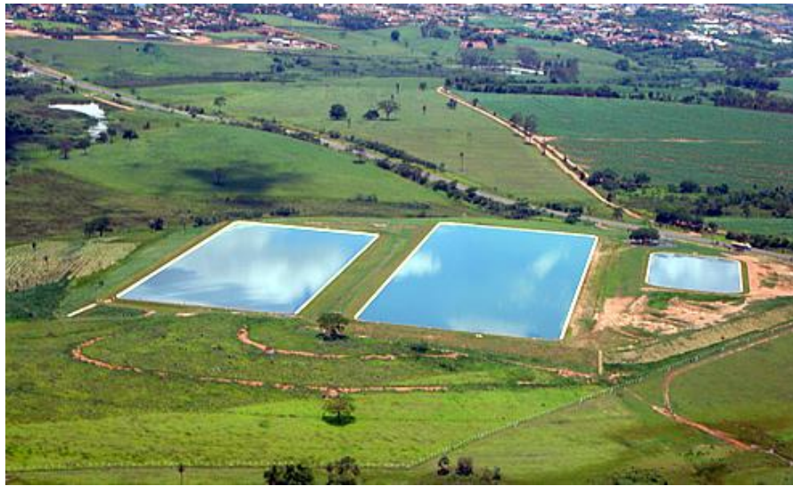
Figura 4.1 - Lagoa Anaeróbia
