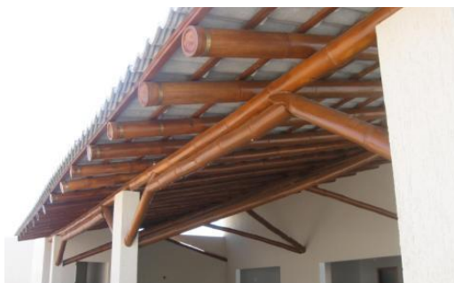
Fig. 37 - Corte reto em peças aparentes Fonte: Rosalino (2011)
