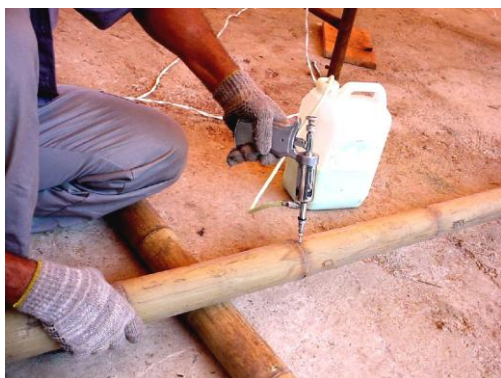
Fig. 79 - Tratamento por injeção Fonte: Nunes (2005)
