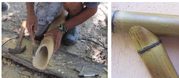
Fig. 39 - Corte "Boca 45°" Fonte: Rosalino (2011)
