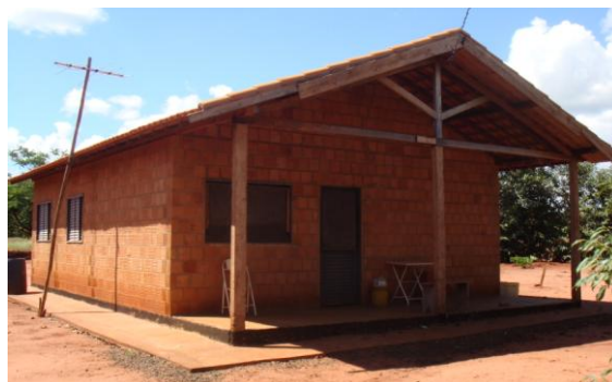
Fig. 86. Casa do Grupo FETAGRI com oitão alterado para tesoura em madeira Fonte: do Autor
