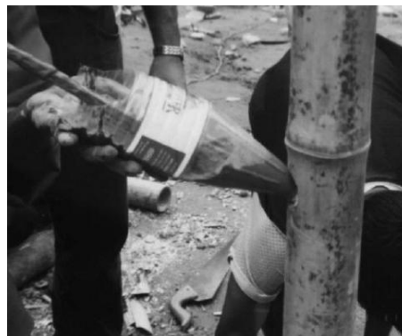
Fig. 33 – Enchimento do colmo com argamassa (utiliza-se funil ou objeto adaptado para tal fim) Fonte: Norma Técnica Peruana E100
