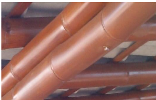
Fig. 60 - União com transpasse de vara Fonte: Rosalino (2011)
