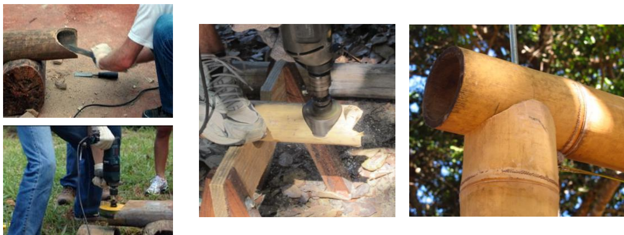
Fig. 38 - Corte "Boca de Pescado" Fonte: Rosalino (2011)
