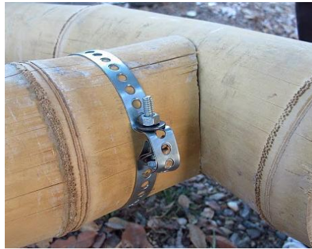
Fig. 43 - Reforço com fita perfurada Fonte: Rosalino (2011)
