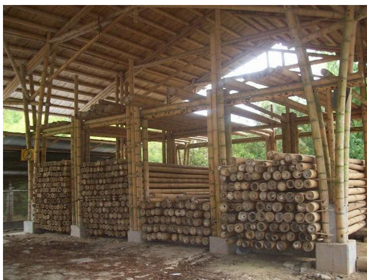
Fig. 82 – Armazenamento das varas de bambu Fonte: Rosalino (2011)
