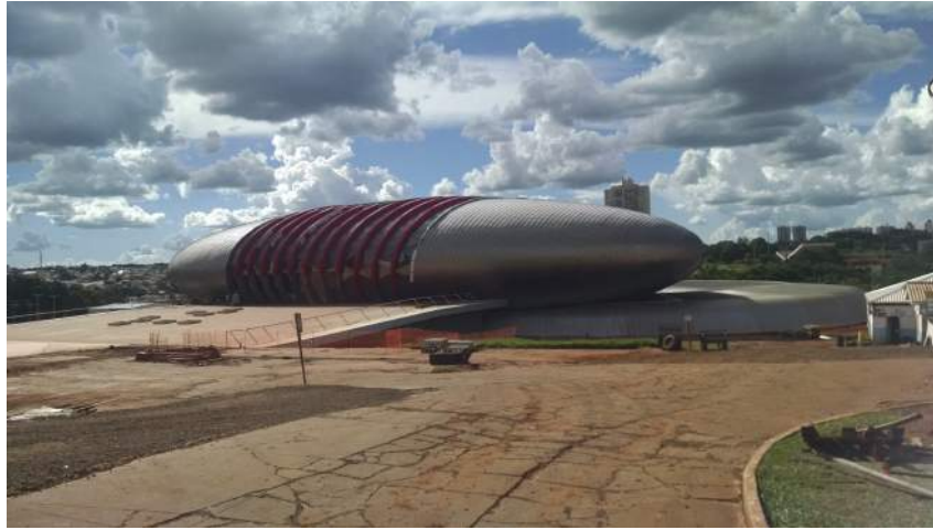
Figura 1.1: Aquário do Pantanal sendo construído na cidade de Campo Grande, Mato Grosso do Sul.
