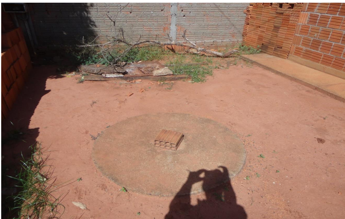
Figura 10: Fossa séptica no conjunto habitacional Lírios. Foto: ALVES SILVA, C.A., 2014.
