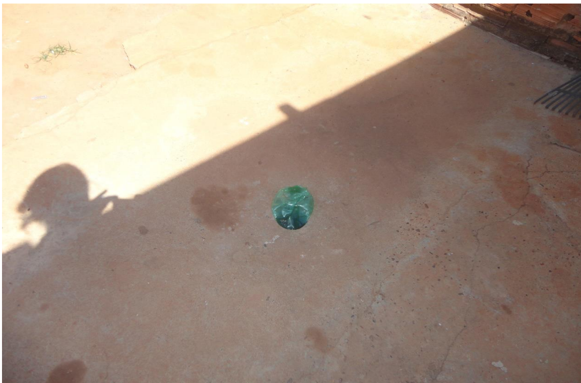
Figura 12: Fossa séptica no conjunto habitacional Violetas II. Foto: ALVES SILVA, C.A., 2014.
