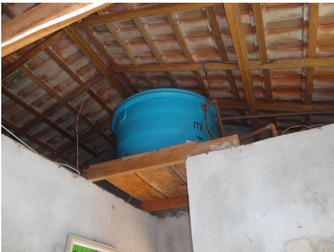
Figura 8: Caixa d'água no Conjunto Habitacional imperial Foto: ALVES SILVA, C.A.,2014.
