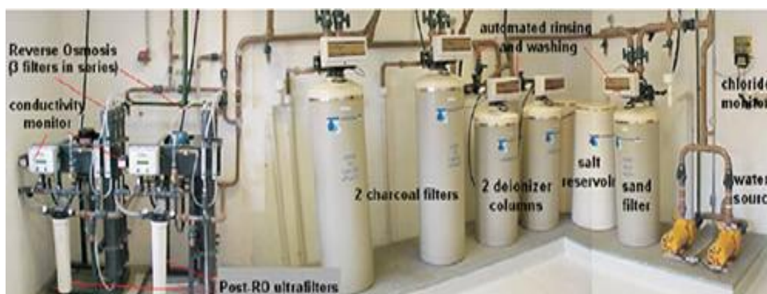
Figura 2. Sistema empregado para tratamento da água a ser utilizada em rotinas de hemodiálise (OLIVEIRA JUNIOR, 2008).
